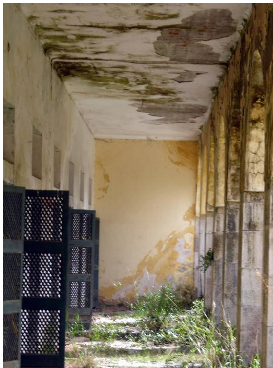
Galeria exterior na fachada Poente
