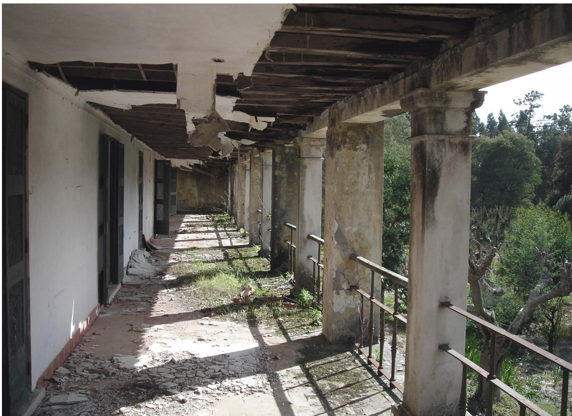
Galeria no piso superior
