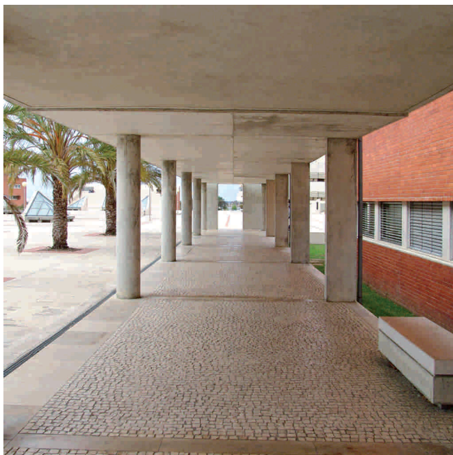
Galeria em betão aparente
