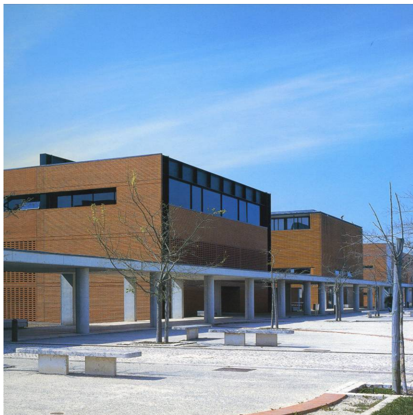
Parte do plano revisto com a utilização do tijolo de barro vermelho com face à vista
