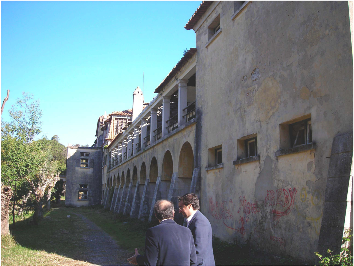
Uma das primeiras reuniões no Hospital, em que conhecemos o edifício a reabilitar
