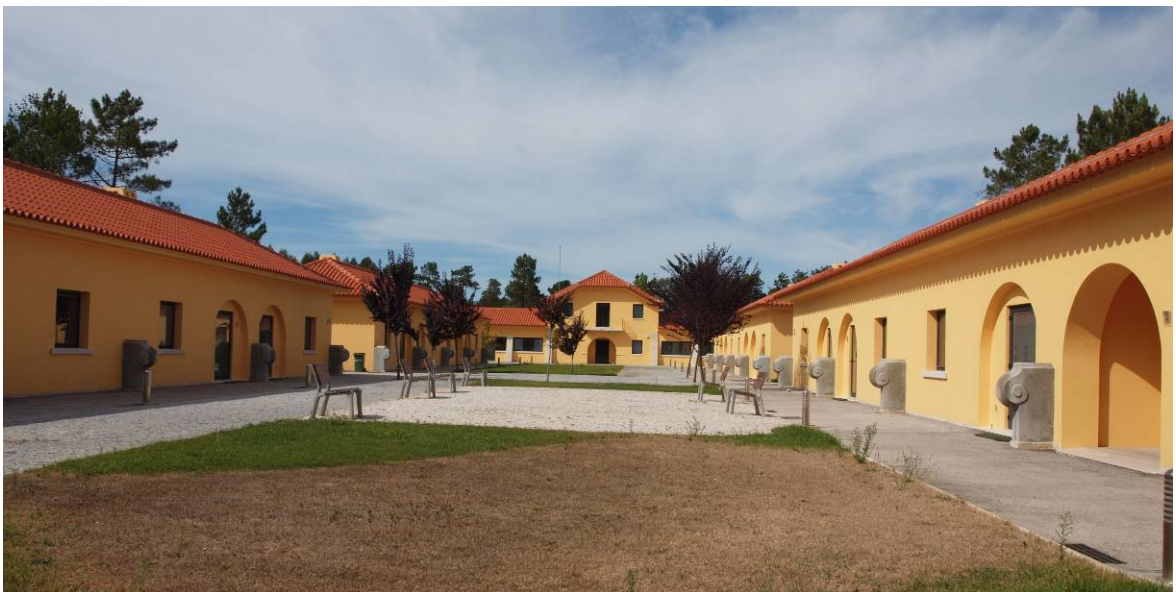
Núcleo familiar recentemente reabilitado
