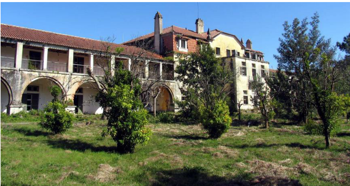
Fachada Principal do edifício a reabilitar
