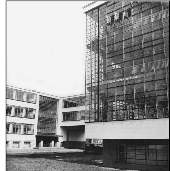
Bauhaus, Dessau, 1926, Walter Gropius. Pormenor da fachada-cortina
