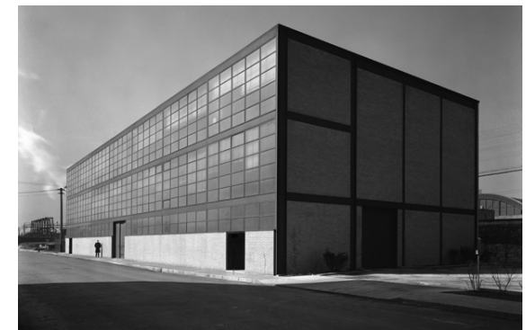
Edifício de Pesquisa de Minerais e Metais, Chicago, 1941/42, Mies van der Rohe
