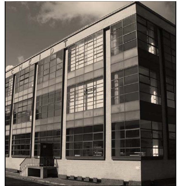
Fábrica Fagus, Alfeld-an-der-Leine, 1913, Walter Gropius. Pormenor da esquina envidraçada
