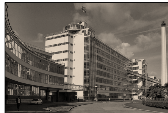
Fábrica Van Nelle, Roterdão, 1926-29. Vista geral
