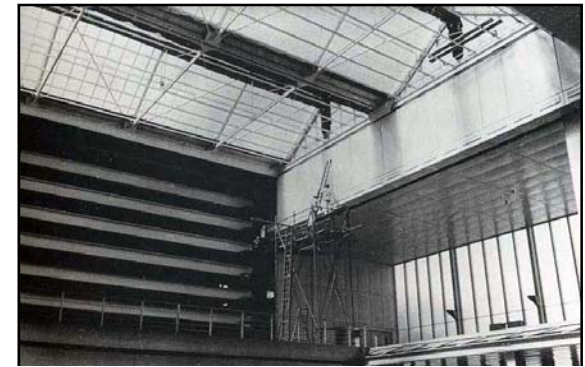
Cada do Povo de Clichy, 1935/39, Jean Prouvé. Interior com espaço central aberto
