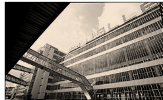
Fábrica Van Nelle, Roterdão, 1926-29. Pormenor da fachada e das pontes envidraçadas
