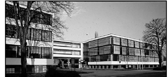
Bauhaus, Dessau, 1926, Walter Gropius. Vista geral dos blocos de ensino e do bloco-ponte
