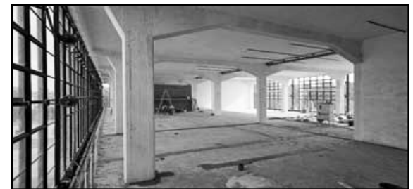
Bauhaus, Dessau, 1926, Walter Gropius. Vista do interior do bloco dos Laboratórios
