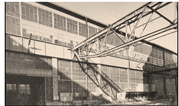
Fábrica de Turbinas AEG, Berlim, 1909, Peter Berhens. Fachada interior
