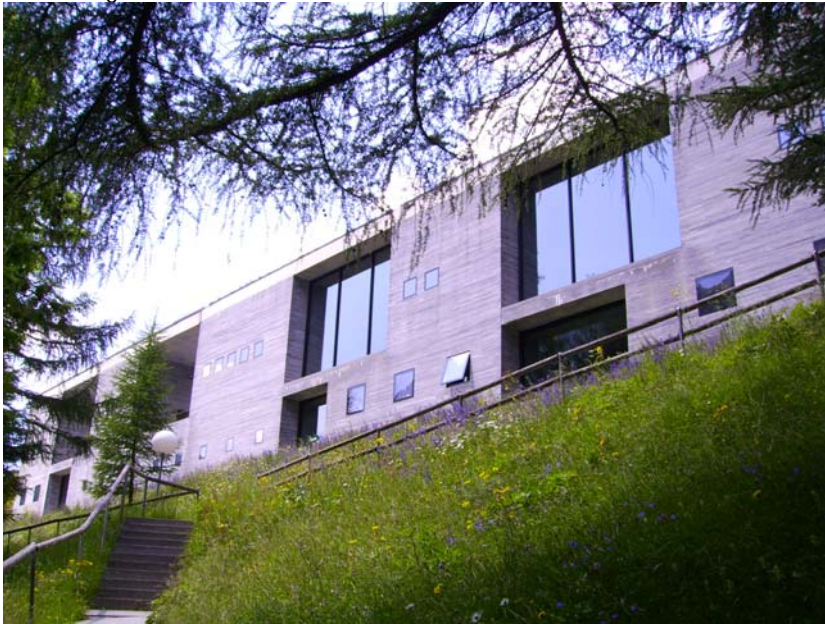
Figura 45 – Fachada do edifício das Termas de Vals. Fonte: original, 2008.
