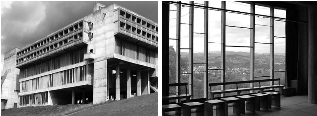
Figura 10 – Convento de La Tourette: vistas exterior e interior da fachada. Fonte: GLYNN, Simon - La Tourette Monastery
