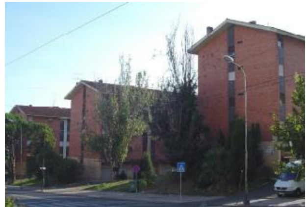
Figura nº 66. Vista Lateral Blocos Tipo A.
