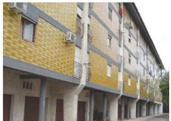
Figura nº 70. Vista Posterior dos Blocos Tipo AA.
