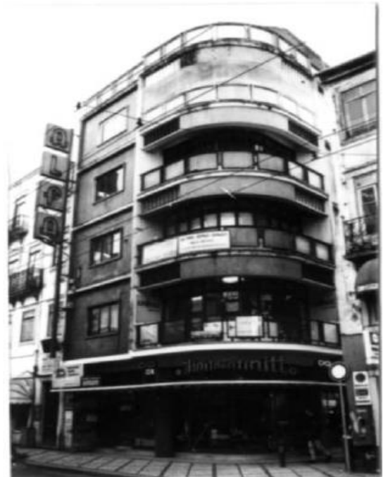
Figura nº7, Edifício projectado por Carlos de Almeida onde se encontrava o seu atelier na rua da Sofia nº99, Coimbra.
