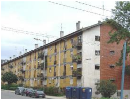
Figura nº 69. Vista Frontal dos Blocos Tipo AA
