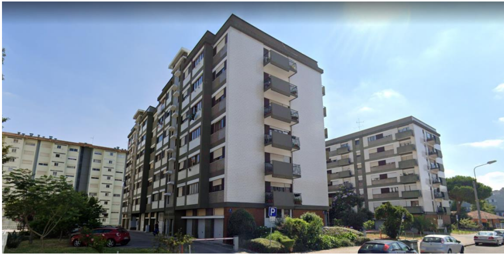
Figura nº77. Vista lateral dos blocos Tipo B
