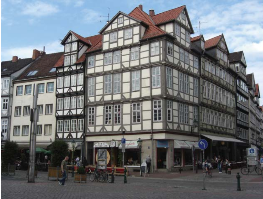
Edifícios de madeira recuperados na Kramerstraße .
