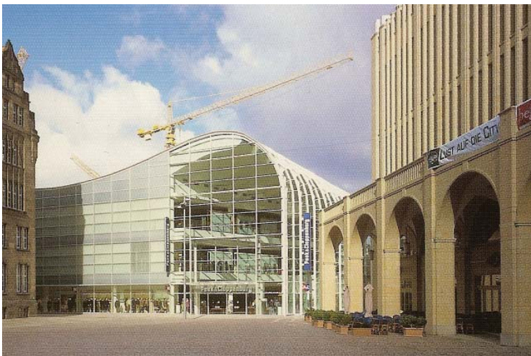
Peek & Cloppenburg (Ingenhoven, Overdiek und Partner, 2002-2003). Galeria comercial de roupa. À esquerda a Câmara Municipal. À direita a Galeria "Roter Turm".
