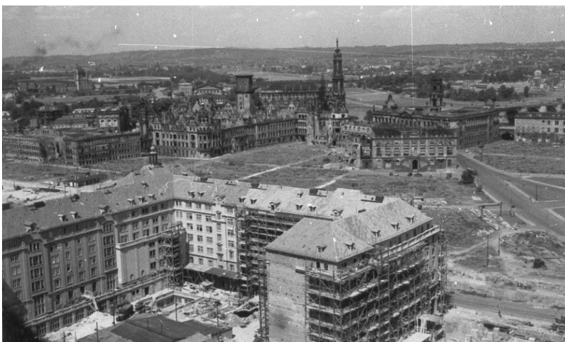
Vista da torre da Câmara Municipal de Dresden sobre a Wildsdruffer Straße . Em primeiro plano vê-se a obra da ala leste dos edifícios do Altmarkt e Ernst-Thälmann-Straße . 1956.
