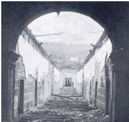
Imagem 115– Aspecto da galeria das celas
