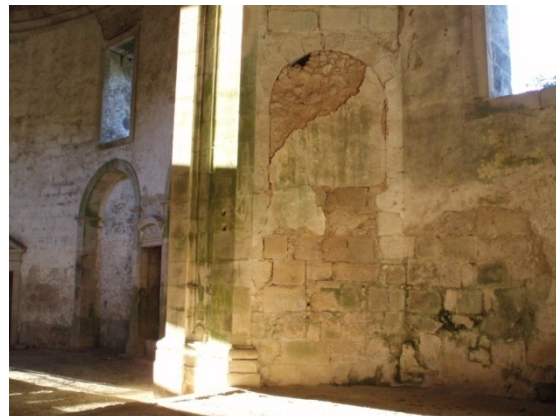
Imagem 84 – Aparelho da igreja (interior)
