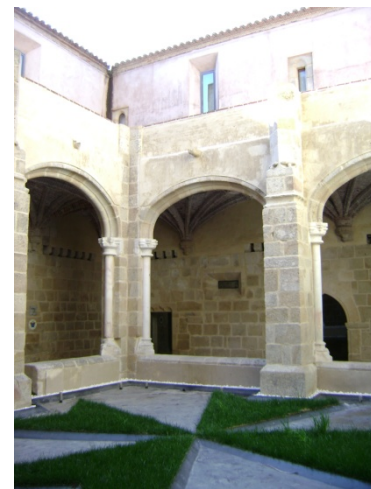
Imagem 139 – Vista actual (inferior)
