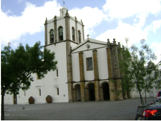
Imagem 152– Fachada poente (entrada)
