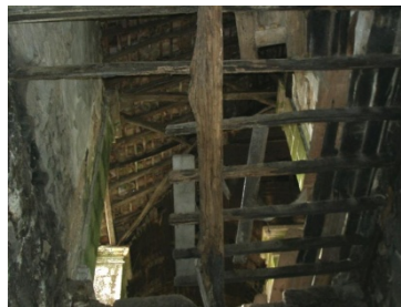
Imagem 16 – Pavimento segundo piso
