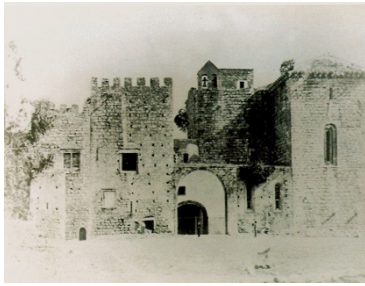
Imagem 134– Fachada principal antes de 1897
