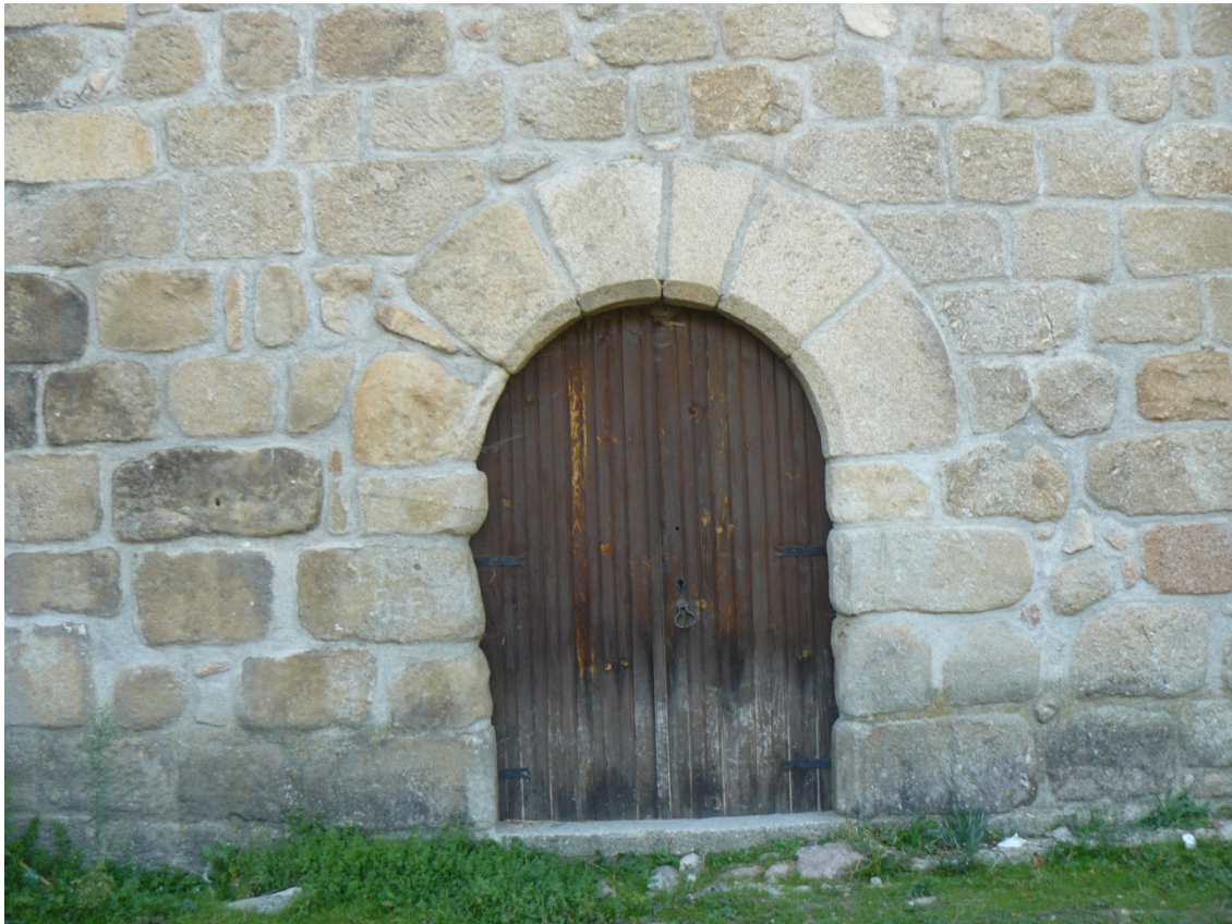
Imagem 82– Aparelho do torreão
