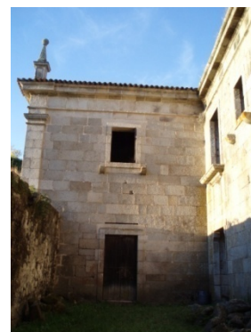
Imagem 69 – Vista da portaria
