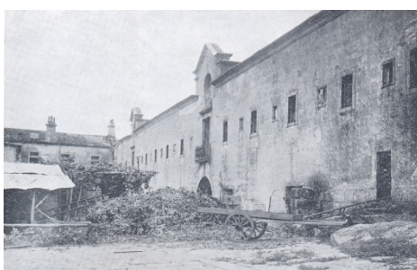
Imagem 119– Aspecto do convento do lado sul-poente
