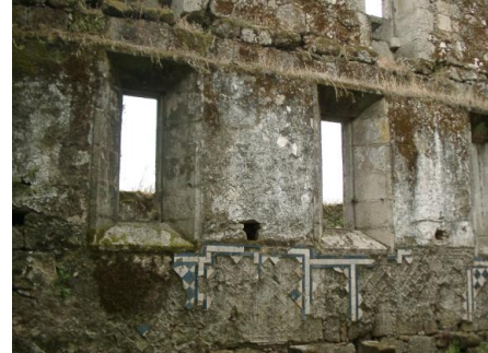
Imagem 14 – Paredes do refeitório
