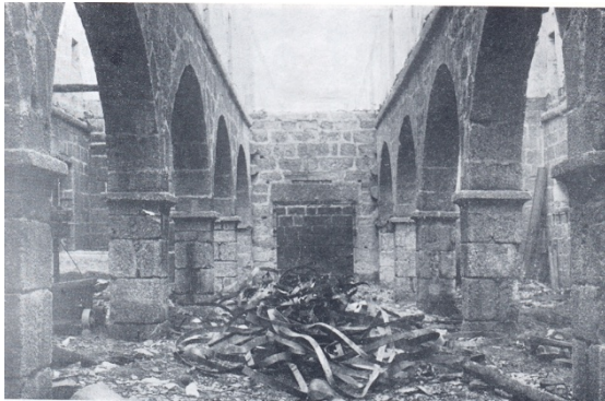
Imagem 113– Aspecto da Arcaria dos “fundos” do convento
