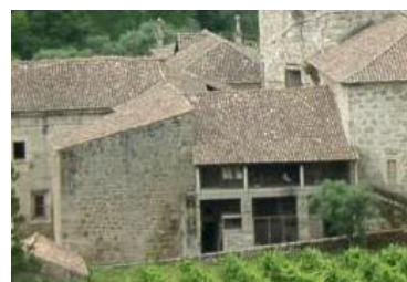
Imagem 43 – Fachada nascente do torreão
