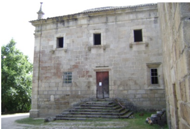
Imagem 44 – Fachada nascente do edificado conventual
