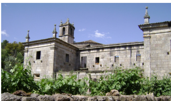
Imagem 46 – Fachada nascente do edificado conventual
