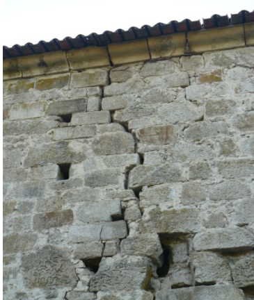
Imagem 6 – Parede nascente da igreja
