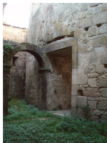
Imagem 61 – Ligação interior à igreja
