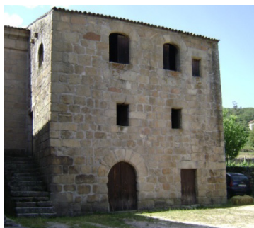
Imagem 42 – Fachada sul do torreão
