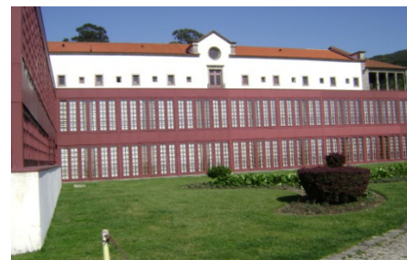
Imagem 118– Aspecto actual (fachada sul)
