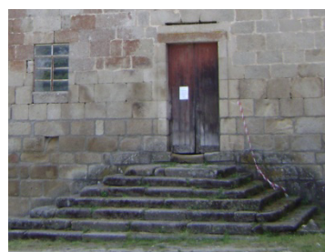
Imagem 55 – Entrada nascente - portaria antiga
