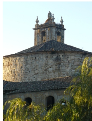
Imagem 50 – Vista da igreja e torre sineira
