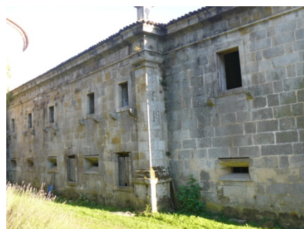
Imagem 47 – Fachada sul do edificado conventual
