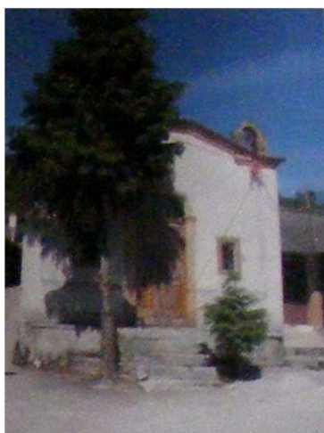
Fig. 15 – Capela antes da intervenção.
