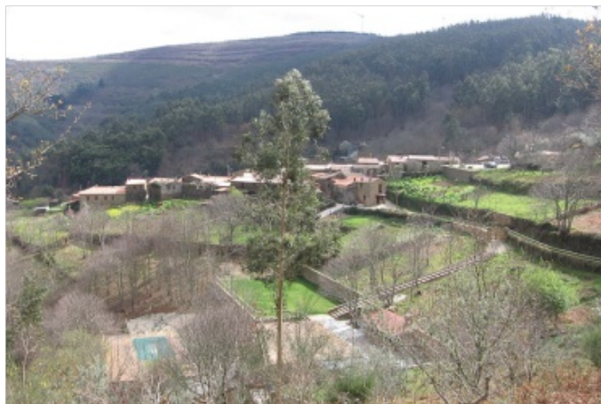
Fig.47 – Vista sobre a aldeia após intervenção.
