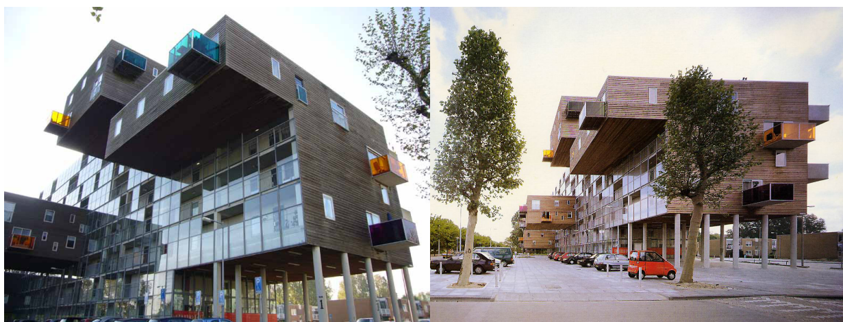
Fig 5 e 6 - vistas exteriores
