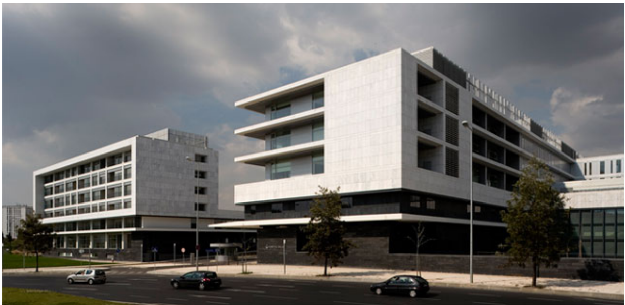
Fig 5 - Vista exterior do complexo
