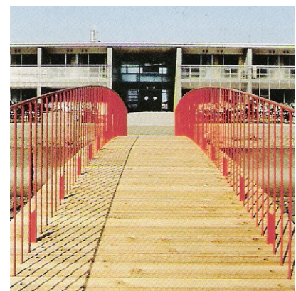
Fig 13 - ponte e zona de entrada
