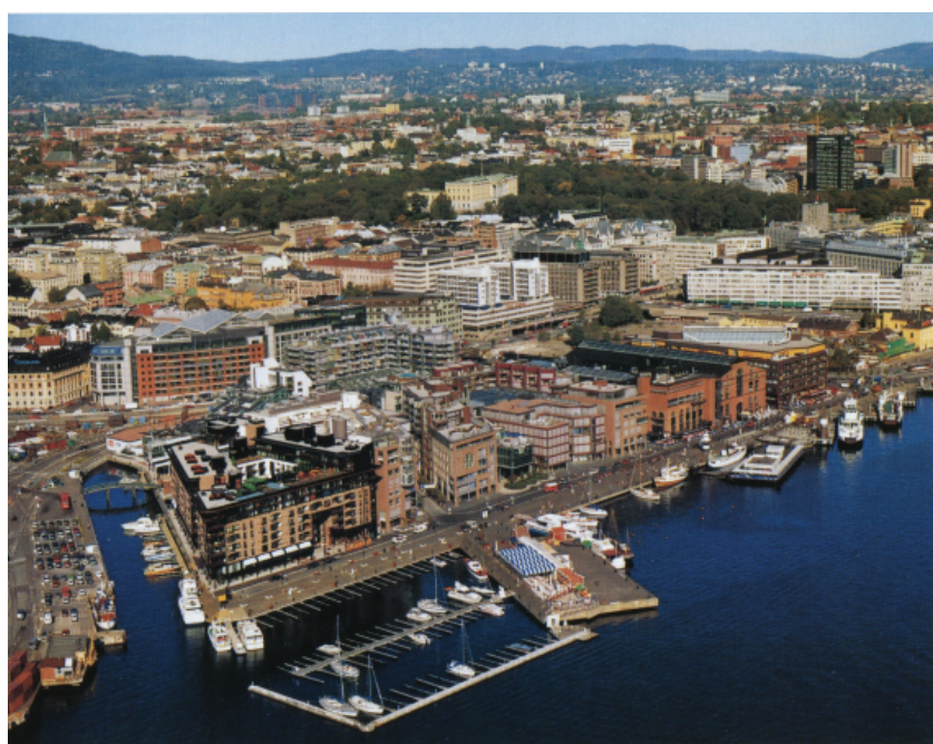
Oslo, década de 90. Revitalização feita no antigo estaleiro de Akker Brygge, podendo observar-se alguns edifícios portuários que ficaram, agora misturados com outros, contemporâneos.
