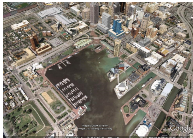
Baltimore, 2009. Inner Harbour após intervenção.
