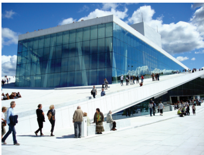
Oslo, 2008. A cobertura do edifício da Ópera de Oslo funciona como espaço público para a cidade.
