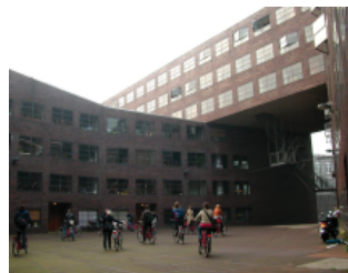
Edifícios de escala monumental na ilha de KNSM.
