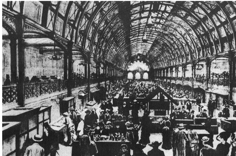
[81+82] Palácio de Cristal do Porto (1865), fotografias do interior e exterior.
