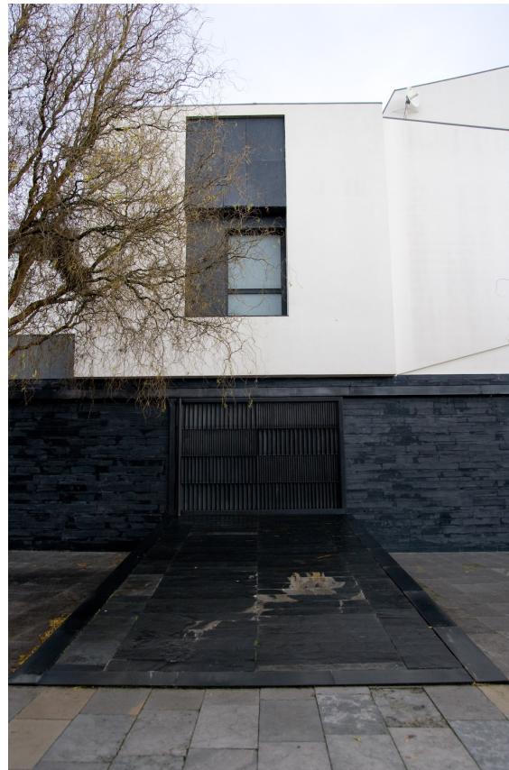
[124] rampa de acesso no alçado norte
