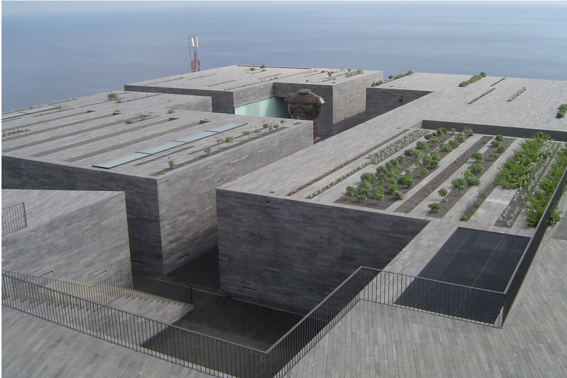
[140] perspectiva sobre a cobertura e sobre o pátio central
