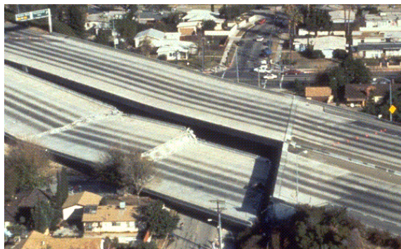
Fig.49 e 50- Conseqüências do sismo em secções elevadas de auto-estradas
