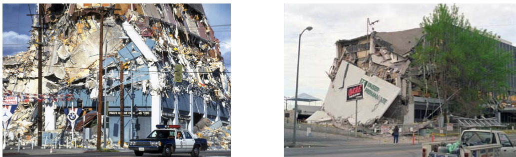
Fig.46 e 47- Edifícios destruídos como consequência do sismo
