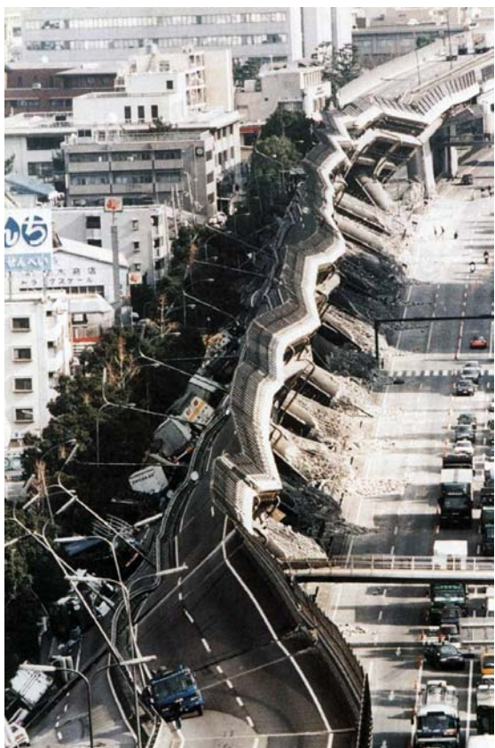
Fig.65- Colapso de meio quilómetro da auto-estrada
