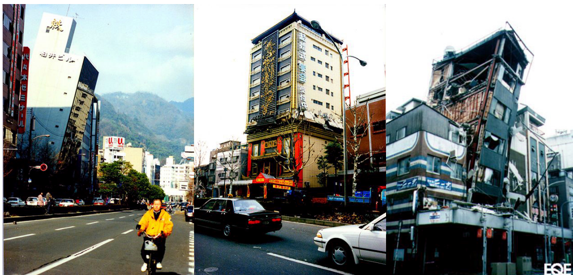
Fig.72,73 e 74- Danos no edificado provocados pelo sismo e pela liquefacção do solo
