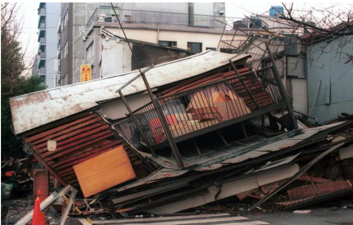
Fig.59- Colapso de um edifício de madeira
