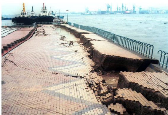
Fig.67- Danos provocados pela liquefacção no Porto de Kobe
