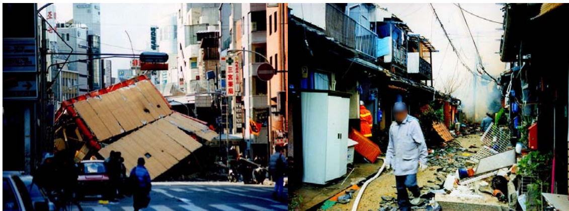
Fig.68 e 69- Danos provocados pelo sismo ao edificado
