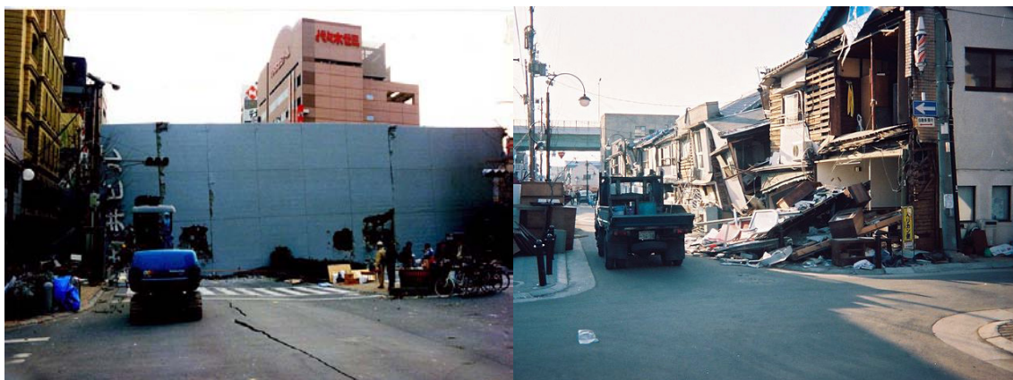
Fig.70 e 71- Danos provocados pelo sismo ao edificado, na imagem da esquerda o edifício colapsou sobre a estrada
