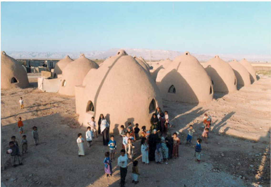
Fig.22- Abrigos de emergência feitos com adobe
