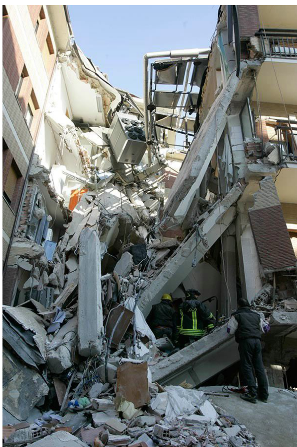
Fig.4- Edifício destruído devido ao Sismo em Áquila a 6 de Abril de 2009
