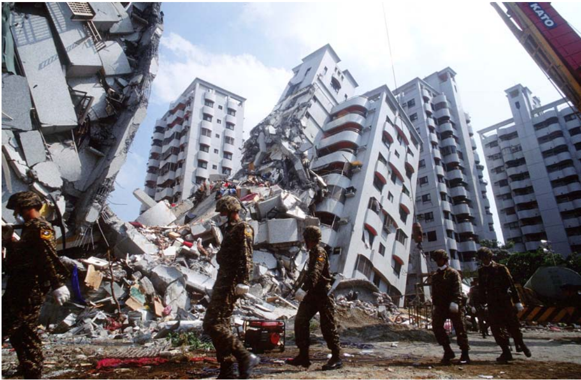
Fig.12- Comportamento indesejável do edificado após um sismo (Tailândia 1999)
