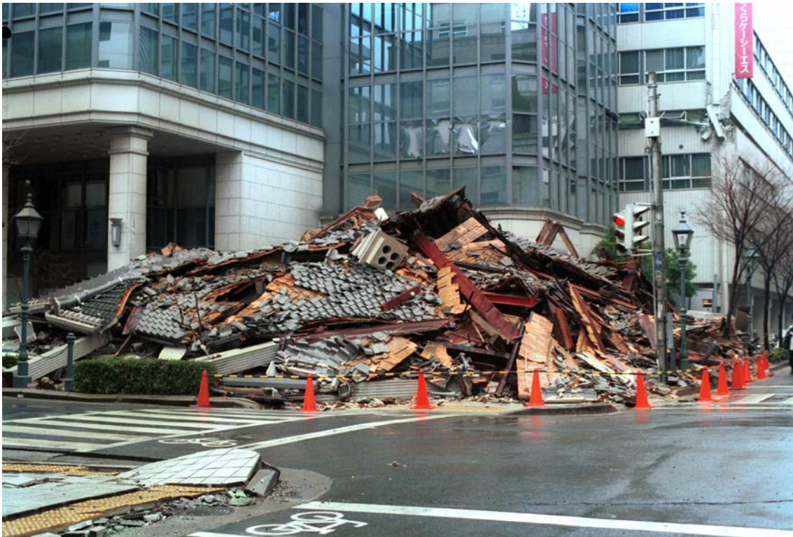
Fig.58- Fotografia ilustrativa dos três tipos de danos no edificado de diferentes épocas. O primeiro edifício de madeira colapsou totalmente, o segundo edifício mais recente apenas sofreu danos ligeiros na fachada e o terceiro edifício construído nos anos 60 sofreu o colapso parcial de um dos seus pisos
