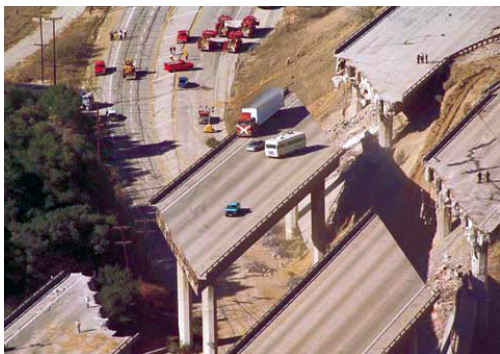
Fig.49 e 50- Conseqüências do sismo em secções elevadas de auto-estradas
