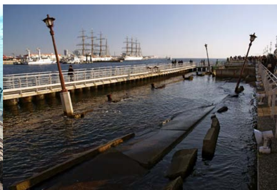
Fig.67- Danos provocados pela liquefacção no Porto de Kobe
