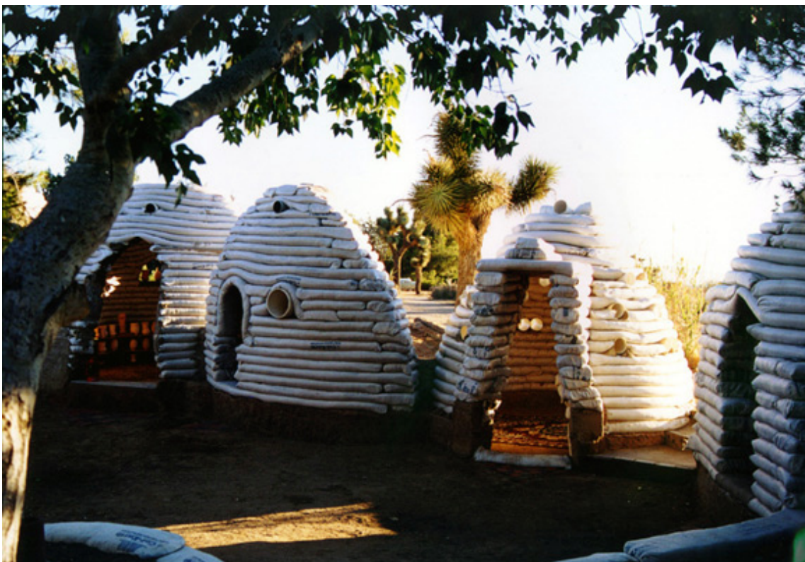
Fig.20- Abrigos de emergência feitos com sacos de terra
