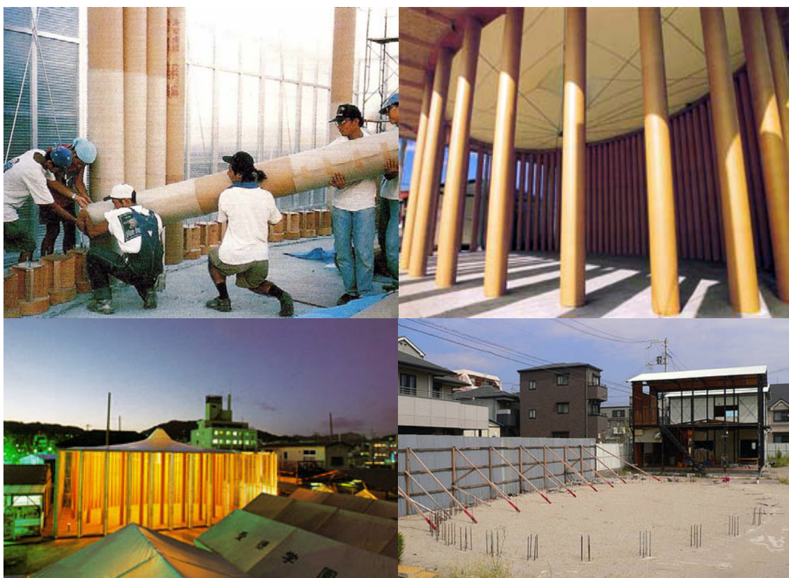
Fig.62- Diferentes fases da Paper Church. Processo construtivo. A igreja vazia. Vista à noite com as tendas de emergência ainda montadas. Após a sua desmontagem em 2005
