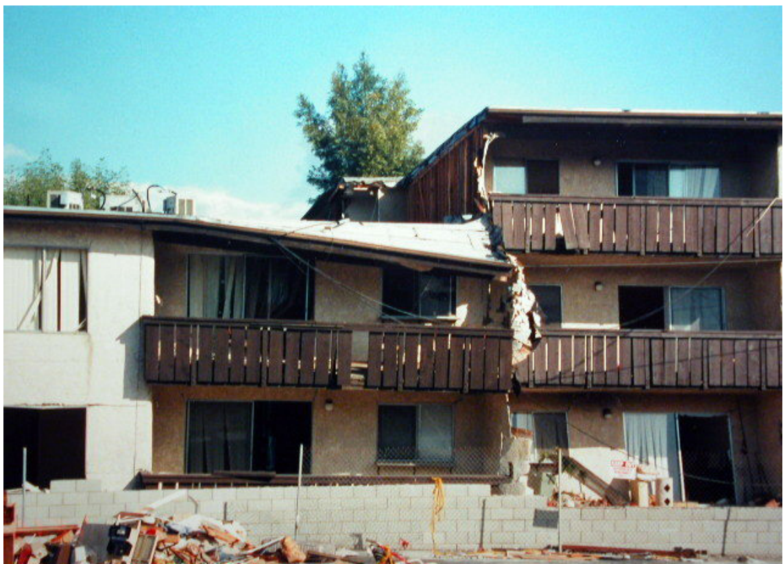
Fig.48- Consequências do sismo num edifício com estrutura de madeira
