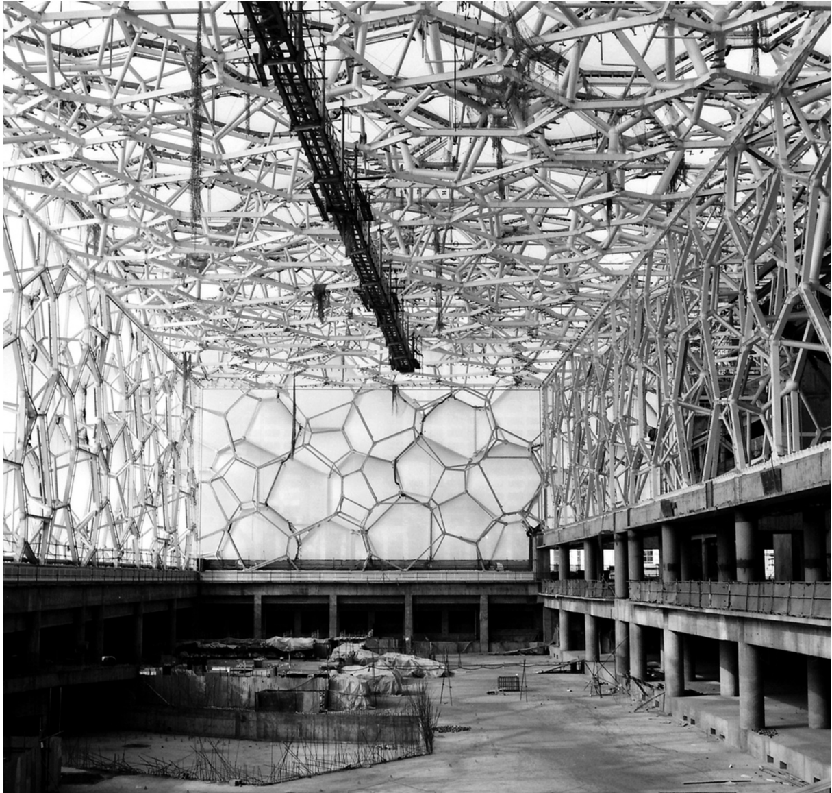
FIG. 65 Aspecto interior da construção do Cubo de Água, PTW, Pequim, 2004-08.
