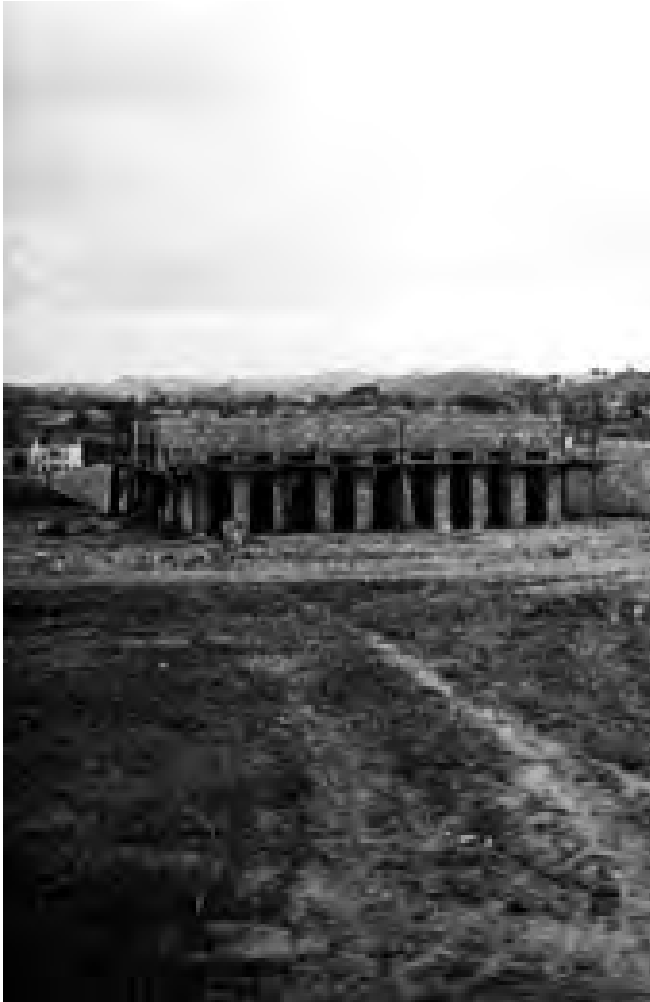
Imagens da construção do Estádio Municipal de Coimbra, na zona do Calhabé.
