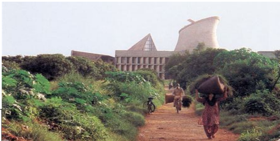
Palácio da Assembleia, Sector 1, Chandigarh, Índia.
