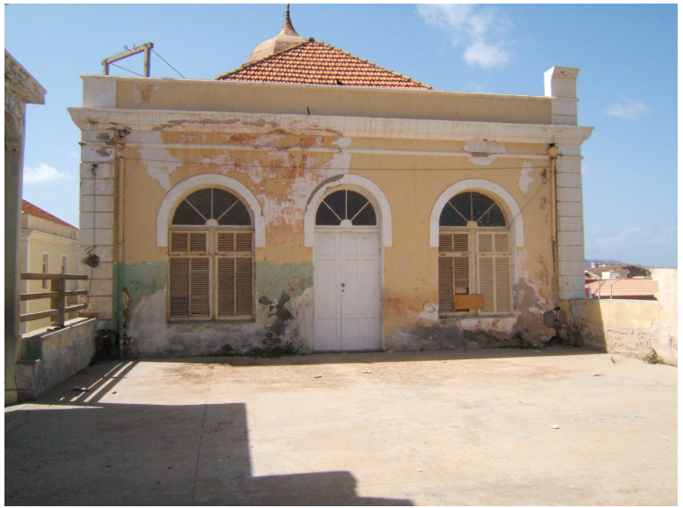
Terraço a Norte (corpo principal)
