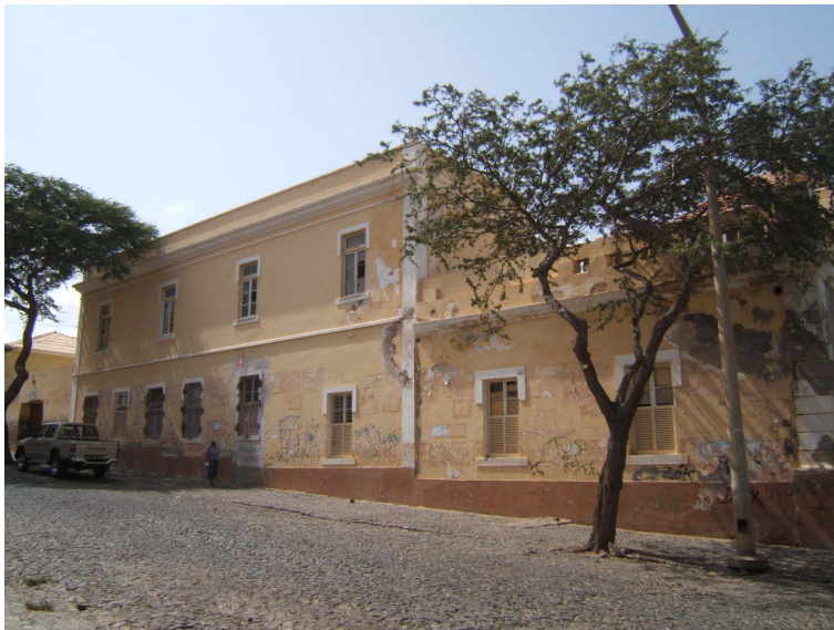
Vista do alçado Norte
