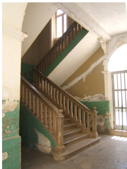
Escada do corpo a Nascente
