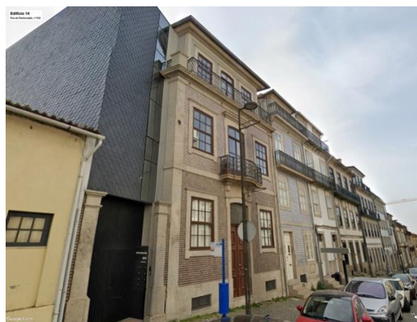
Figura 23 – Rua da Restauração, n.º 432.
