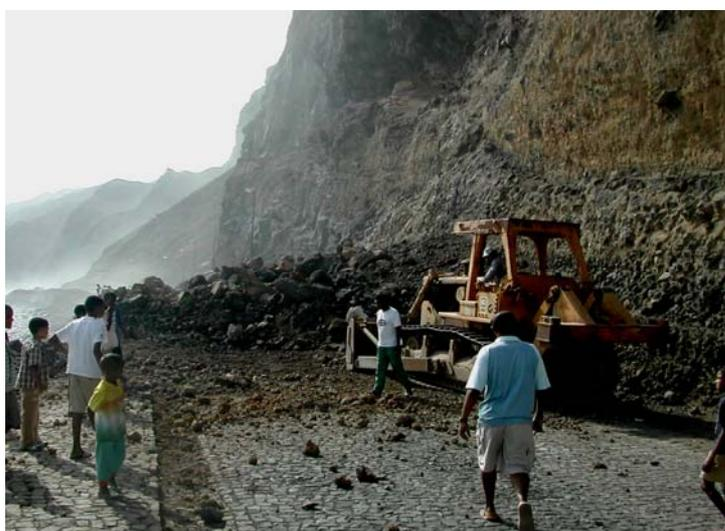
**Foto 1-** Entulhamento e problemas de circulação na estrada de ligação Povoação/Paúl, devido a desabamentos com grande quantidade de materiais depositados na estrada (Fonte: CMRG, 2007)
