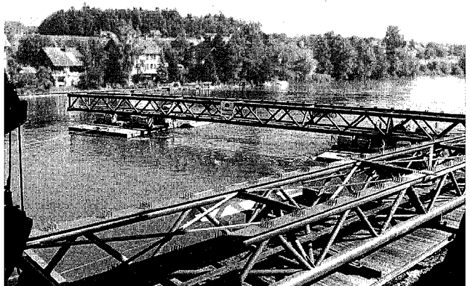
Bild 2. Brücke von Aarwangen im Bauzustand
