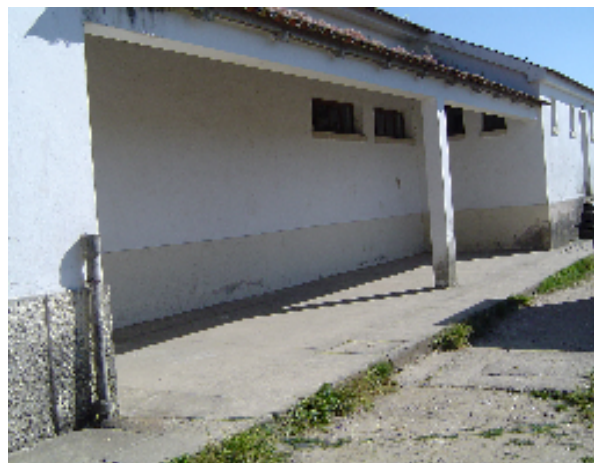
Figura 2: Pátio de trás da escola e patio coberto
