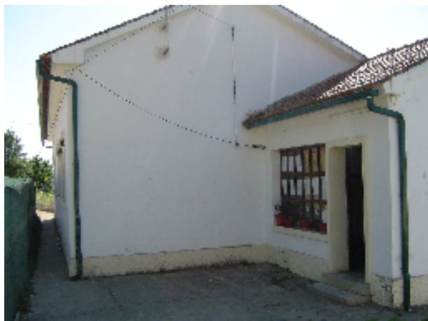
Figura 1: Fachada principal da escola
