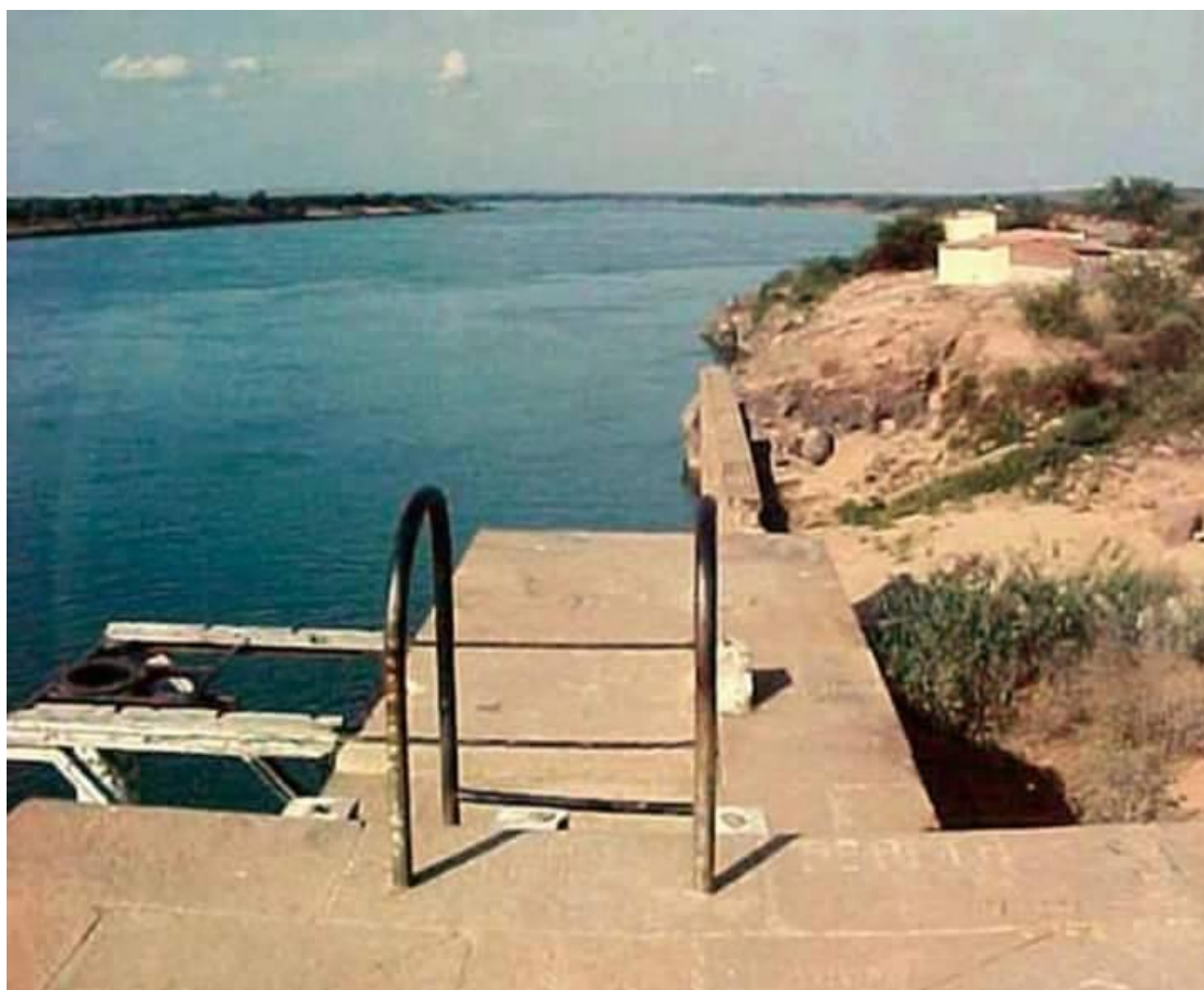
Figura 6 - Cais da antiga Petrolândia
