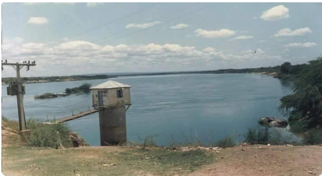
Figura 14 - Estação elevatória de água da velha Petrolândia
