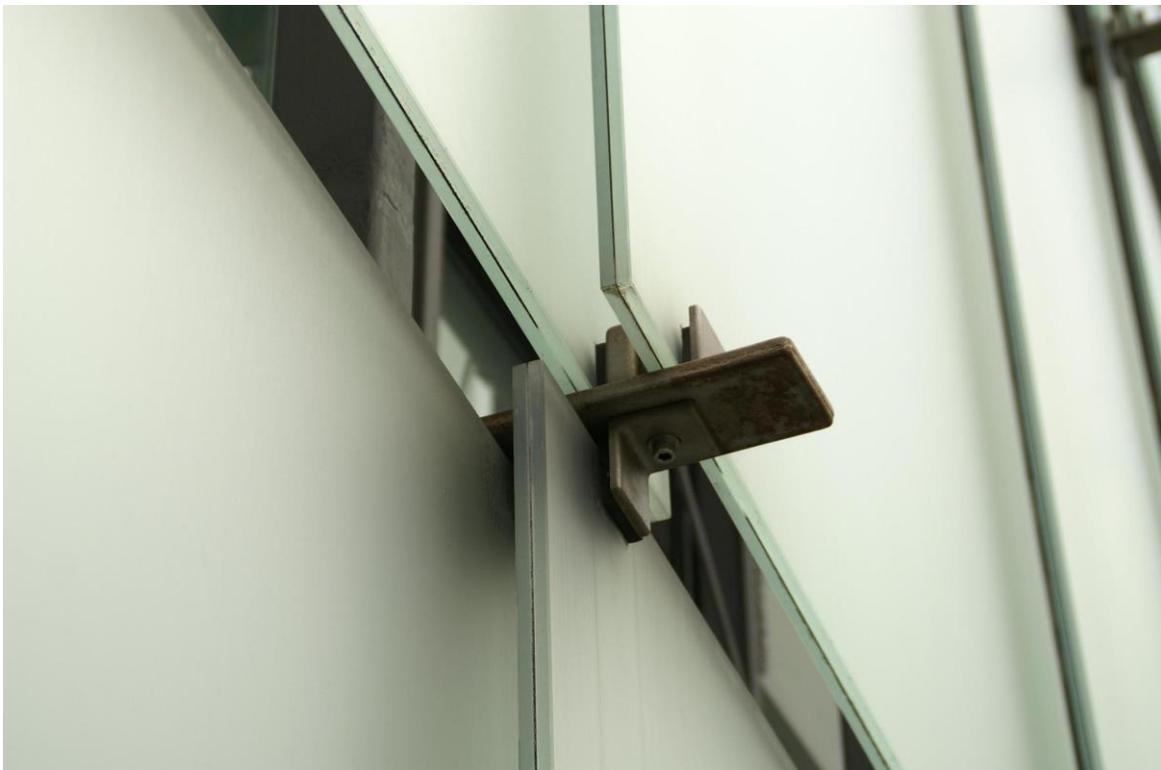
Figura 52. Pormenor do sistema de encaixe dos painéis de vidro em grampo metálico. 2006. © Christopher Schriener
