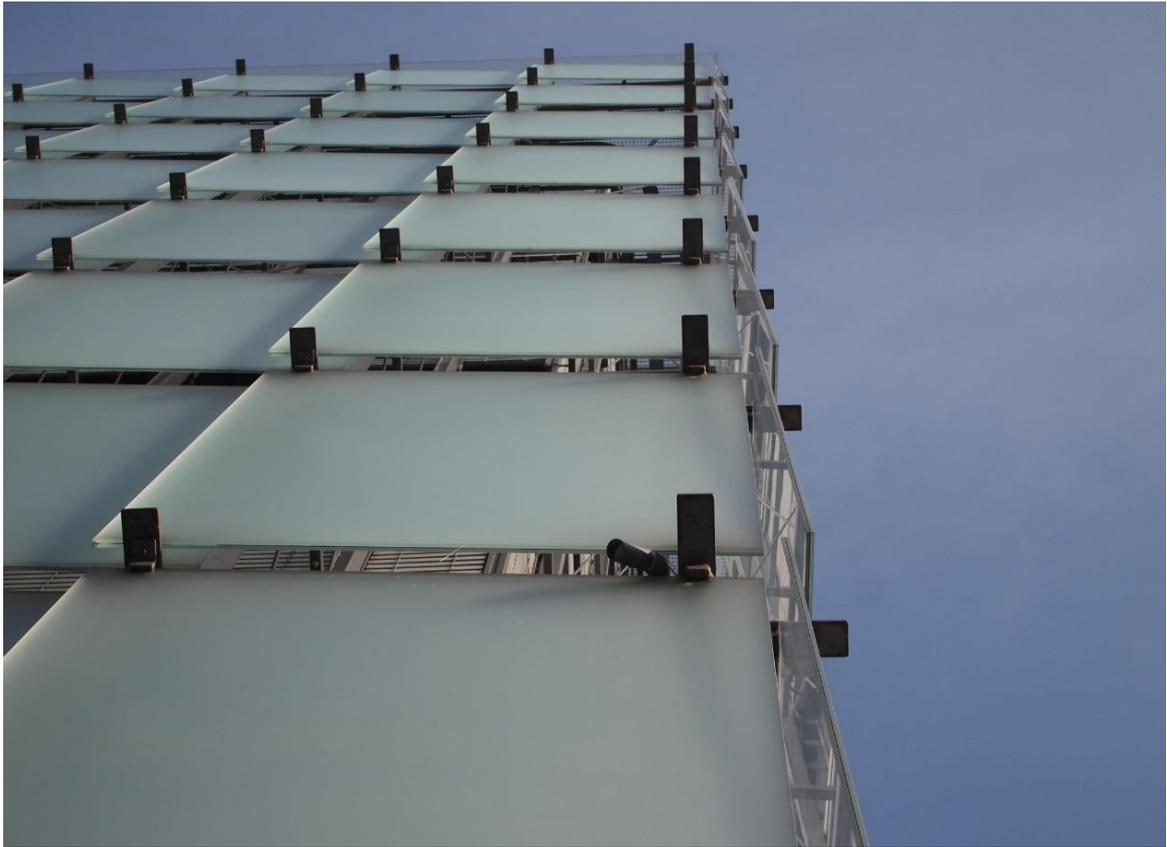
Figura 53. Destaque da sobreposição vertical entre painéis da fachada. 2009. © William
