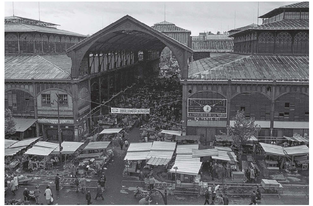
Figura 12. Fotografia exterior da zona de entrada para as galerias cobertas das Halles Centrales de Paris .
