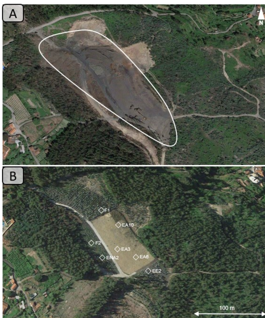
Figura 8 – Imagem aérea da escobreira do Fojo (coordenadas: 41°02'28,06" N; 8°23'02,72"O). A) Área da escobreira durante os trabalhos de reabilitação em 2019. B) Área da escobreira em 2021, com identificação dos locais de amostragem (Google Earth, acedido em maio de 2022).
