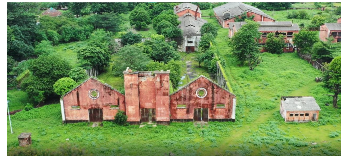
Figura 73: Ilhéu do Rei, vista aérea do principal alçado do hotel.
