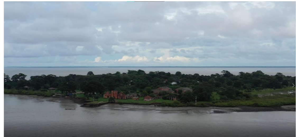
Figura 66: Ilhéu do Rei, vista aérea do complexo fabril.
