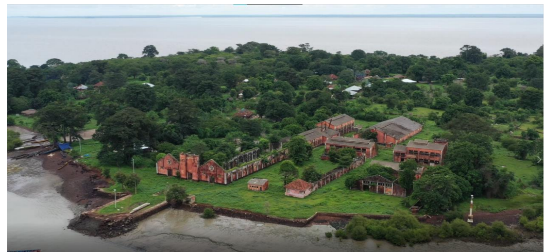
Figura 68: Ilhéu do Rei, vista aérea do complexo fabril.
