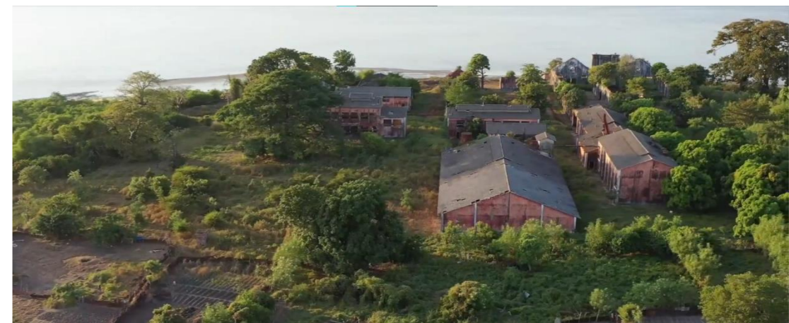
Figura 78: Ilhéu do Rei, vista aérea do complexo fabril.
