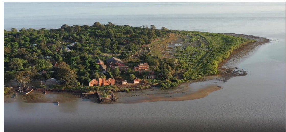
Figura 67: Ilhéu do Rei, vista aérea do complexo fabril.
