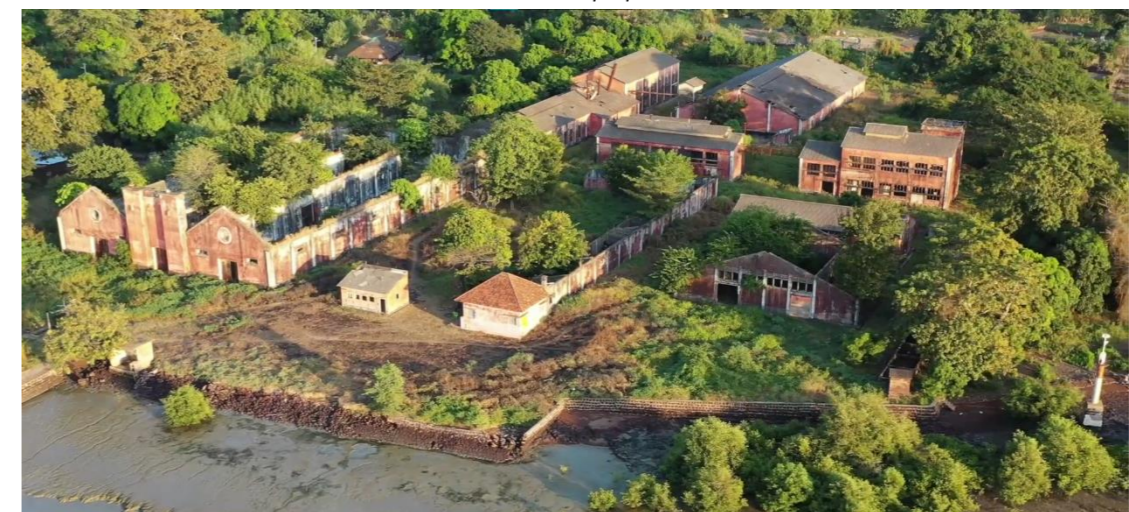
Figura 72: Ilhéu do Rei, vista aérea do complexo fabril.
