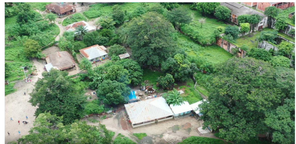
Figura 82: Ilhéu do Rei, vista aérea das habitações existentes.
