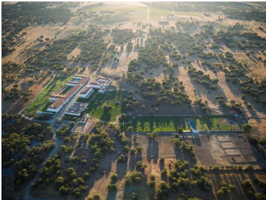
Figura 10: São Lourenço do Barrocal, vista aérea.
