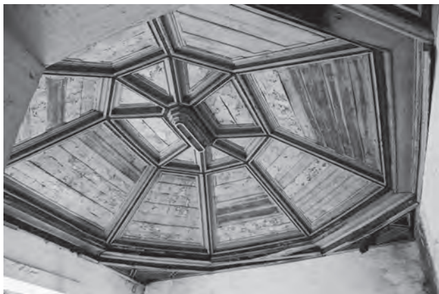
Fig. 49 | Teto em masseira da sala abacial setembro 2020
