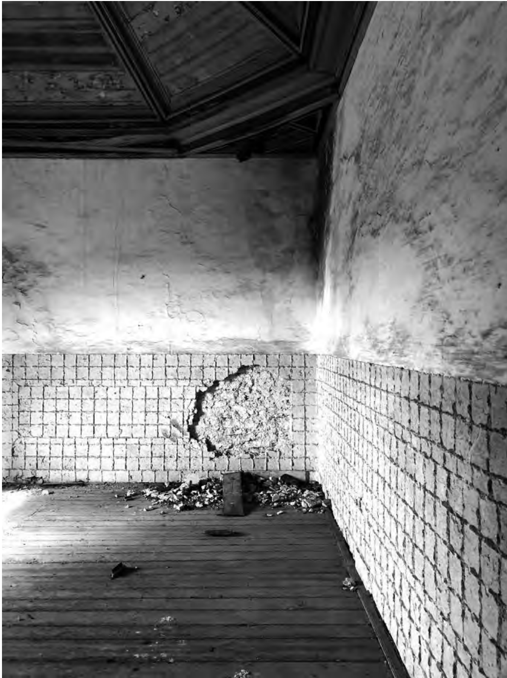
Fig. 62 | Ausência dos azulejos que revestiam a sala abacial setembro 2020
