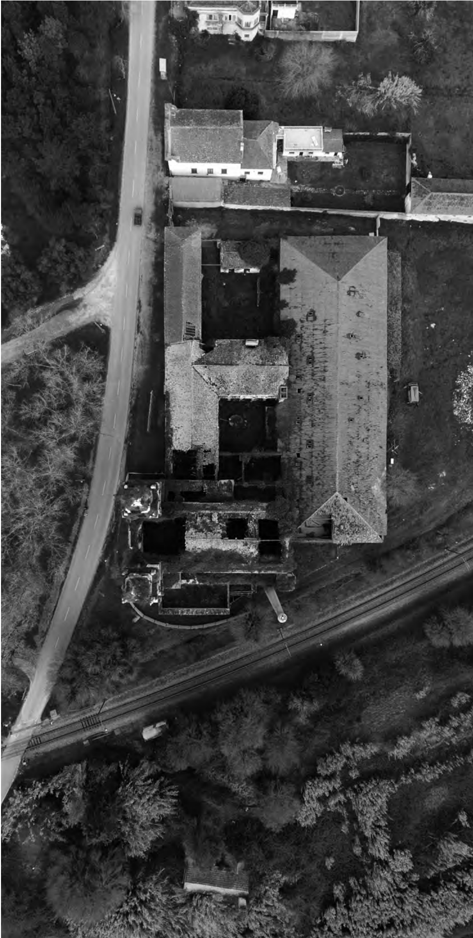
Fig. 46 | Vista aérea do mosteiro
