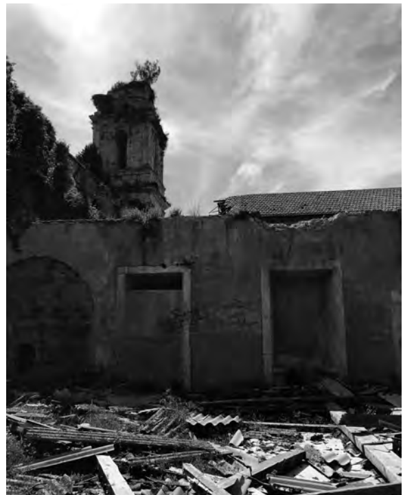
Fig. 59 | Parede resistente da ala nascente com conversadeiras abril 2021
