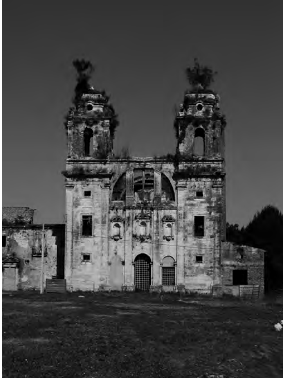
Fig. 52 | Fachada monumental da igreja 2022
