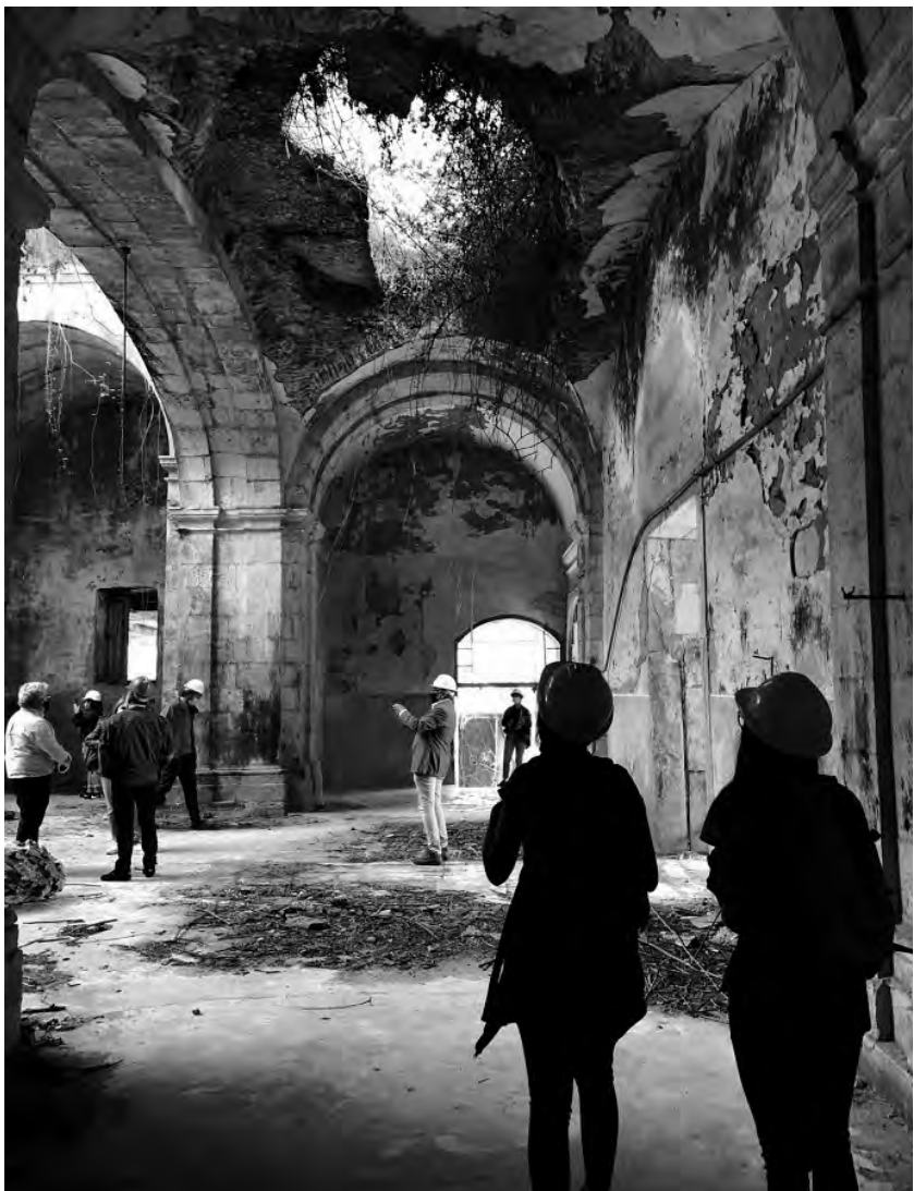
Fig. 48 | Abóbada de aresta em ruína setembro 2020
