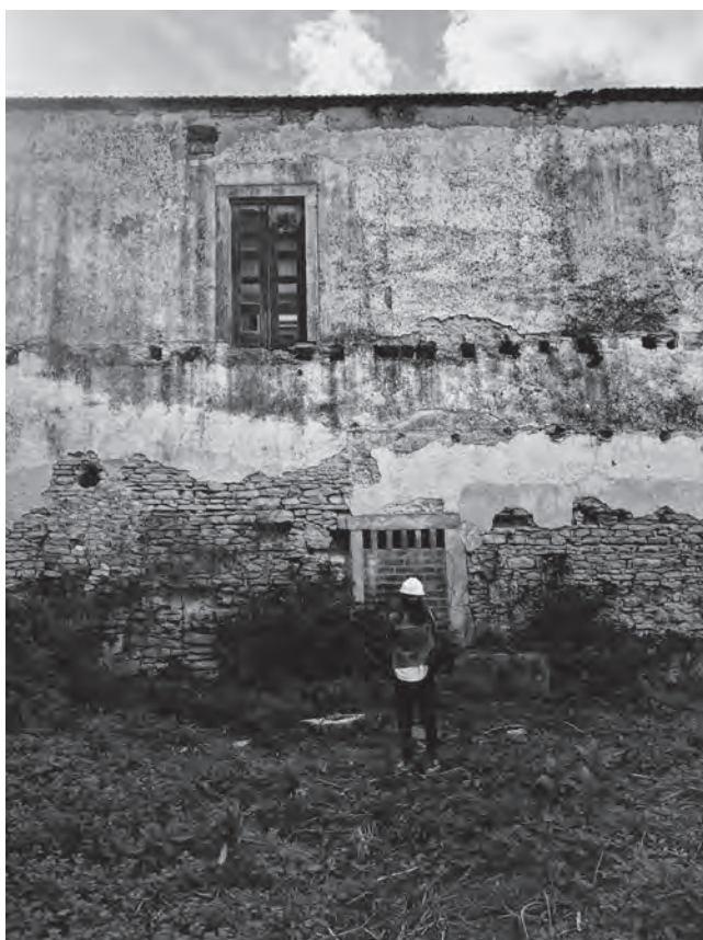
Fig. 50 | Vestígios do arranque da estrutura do segundo claustro setembro 2020
