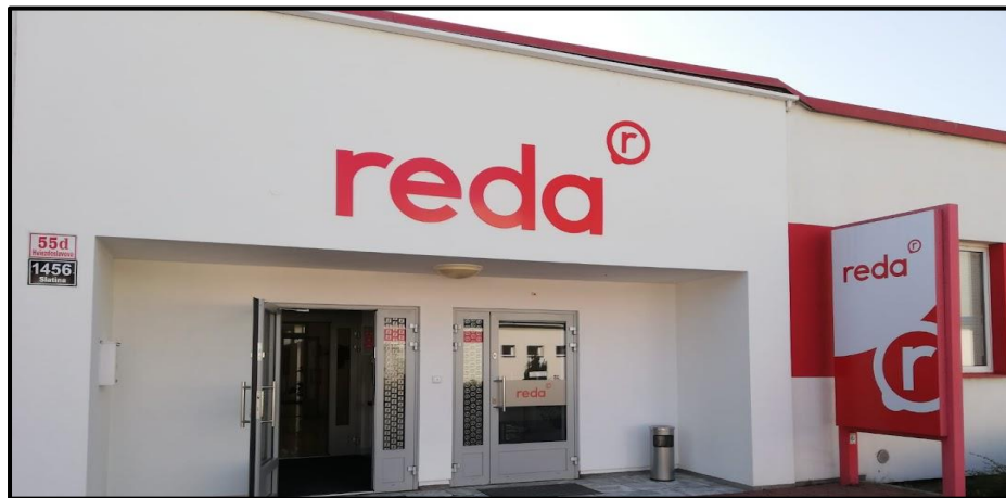
Figura 4.2 Instalações da REDA em Brno
