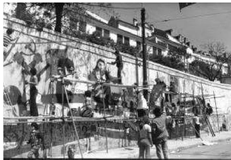
11 - Muro da Escola Jaime Cortesão.
