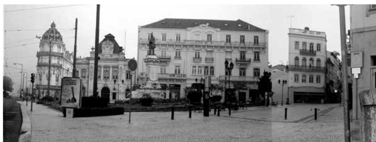
fig. 92. Largo da Portagem atualmente limitado pelo Banco de Portugal
