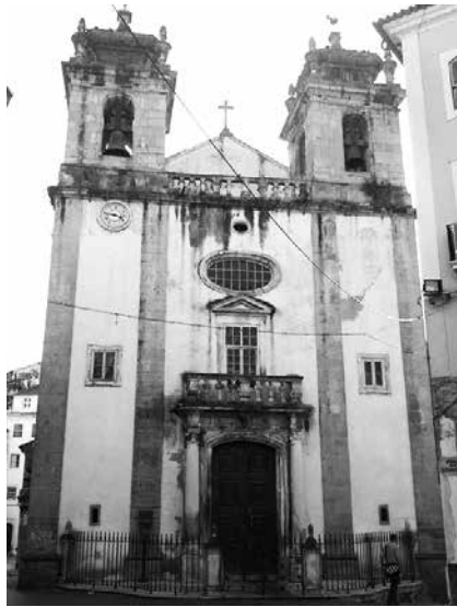
fig. 160. Igreja de S. Bartolomeu atualmente
