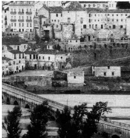
fig. 22. Vigé & Plessix, Largo da Portagem sendo visível a cadeia demolida em 1857, 1856 (Ramires, 2006: 47)
