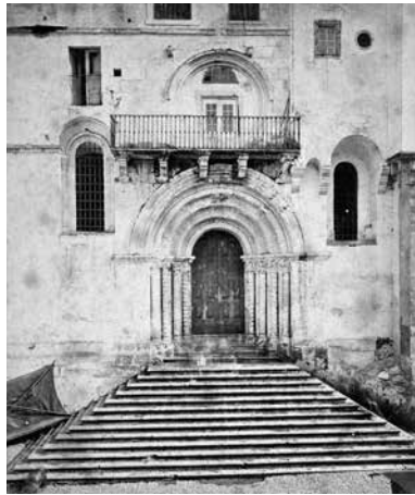
fig. 149. s/a. Igreja de São Tiago [início do séc. XX] (CMC/AG-0055). Antes das obras de restauro
