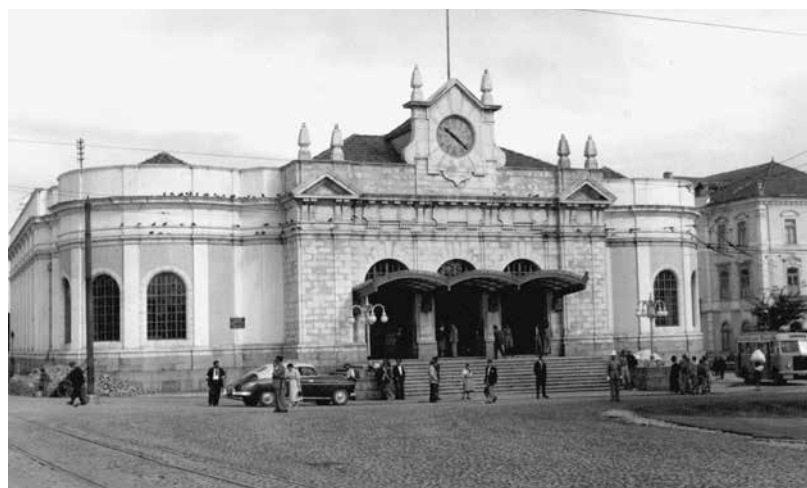
fig. 139. s/a. Estação Nova, 1954 (CMC/BMC- B776)
