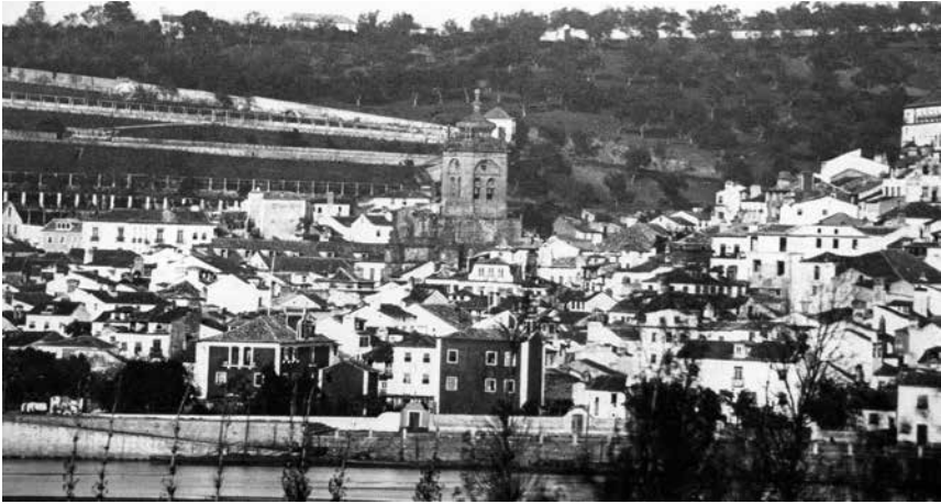
fig. 20. A. Fillon, [margem do rio entre o Largo das Ameias e a ponte, visíveis as escadas para o largo já alteado] c. 1860 (Ramires, 2006: 47)
