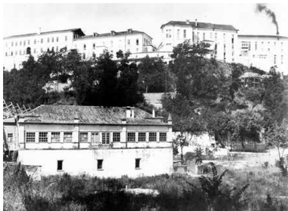
fig. 119. s/a [Vista da encosta com Ninho dos Pequenininos em primeiro plano e ao fundo o Hospital da Universidade], c. 1930 (Associação dos antigos estudantes de Coimbra: 20) São visíveis a substituição e alteamento do telhado do Hospital de S. Jerónimo e à direita o início da construção do edifício da lavandaria
