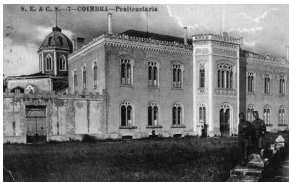
fig. 131. s/a. Penitenciária , s/d (CMC/PB-00513). Edifício administrativo
