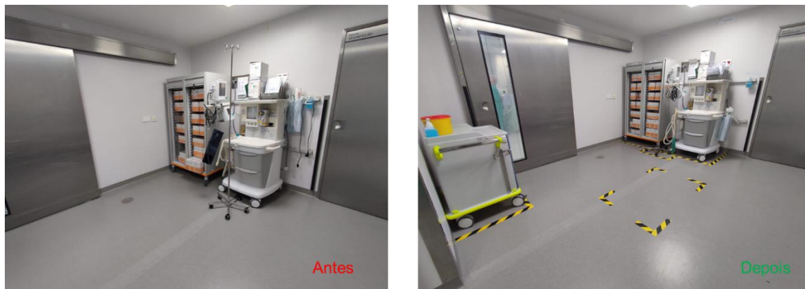
Figura 4.9. Sala de indução 4/5 antes e depois da intervenção
