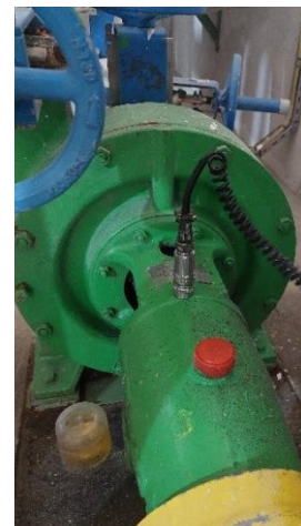
Figura 5.18. Medição vertical com acelerómetro piezoelétrico
