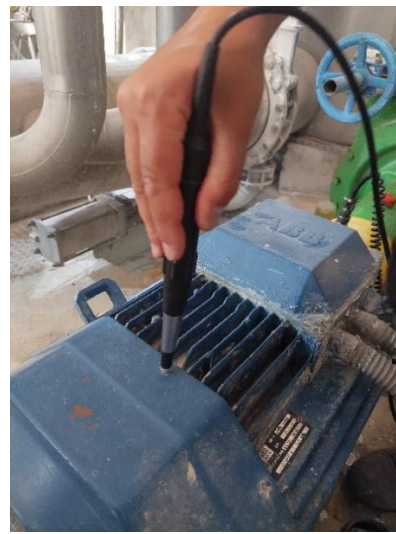
Figura 5.13. Medição em motor elétrico
