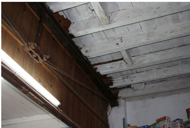
Figura 16. Soluções construtivas originais de reforço de pavimentos.
