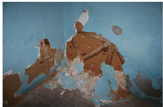
Figura 11. Paredes de alvenaria com estrutura de madeira embecida.
