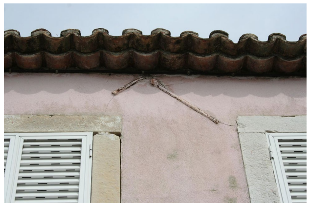
Figura 12. Exemplos da aplicação de tirantes em edifícios do núcleo urbano antigo do Seixal.
