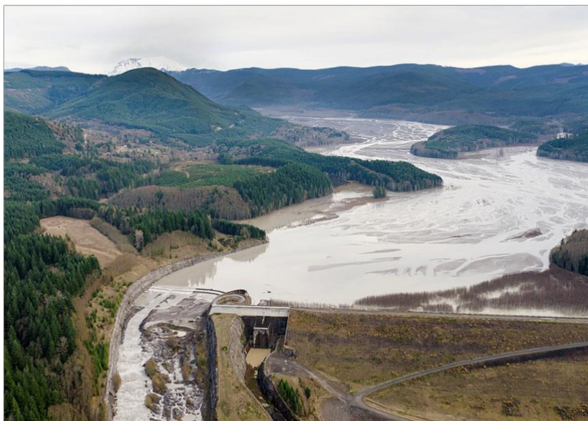
Figura 2.16 – Estrutura de retenção de sedimentos no inverno de 2012 – 2013, no rio North Fork Toutle, em Washington (Sclafani et al., 2017).
