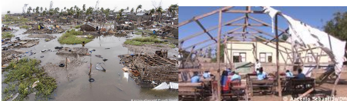
Figura 28 (A e B) Destruição de infraestrutura na sequência dos ciclones Idai e Kenneth na cidade da Beira e em Cabo Delgado
