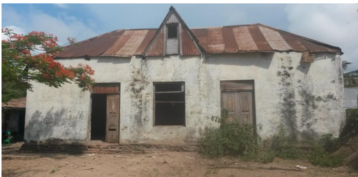
Figura 18 Infraestrutura da década de 1950, de arquitetura resiliente às inundações
