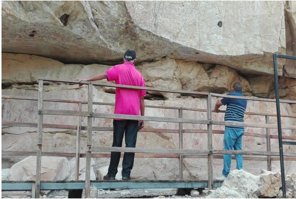
Figura 7.23 - Estrutura de passarela para visitantes apreciarem as pinturas, sem que tenham proximidade com elas. Fonte: Própria da autora.
