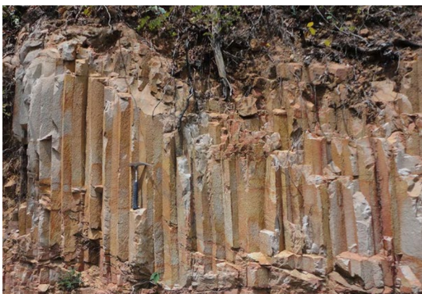
Figura 3.29 – Arenito da Formação Cabeças fraturado segundo duas direções ortogonais (260/820 e 350/880), o que confere à rocha aspecto colunar, próximo à Mina do Boi Morto, Pedro II
