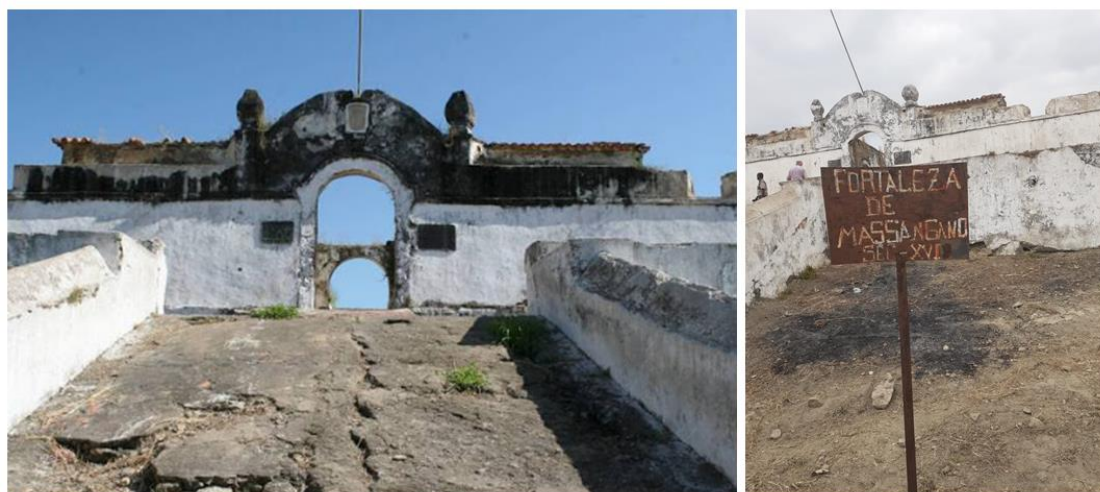
Figura 38. Fortaleza de Massangano, Província de Cuanza Norte
