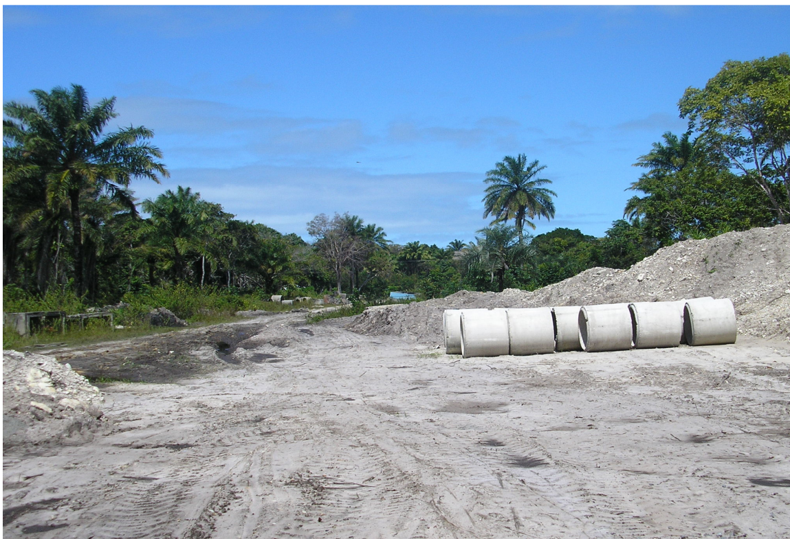
Foto 17 - Construção das mariculturas.
