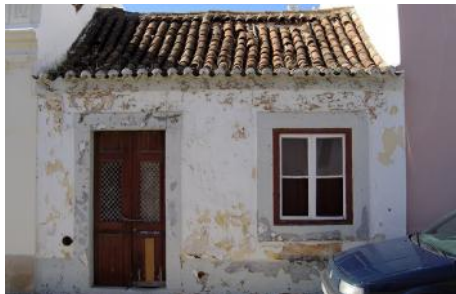
83. Imagem de Edifício Pombalino (P1) (PPSNP-VRSA)
