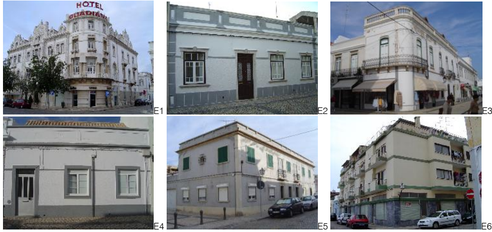
88-93. Exemplos de Edifícios não Pombalinos e respectiva classificação (PPSNP-VRSA)
