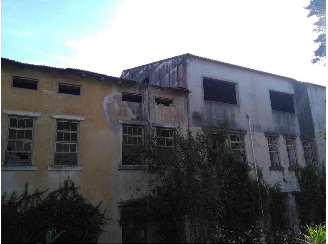
Anexo Nº9 - Abandonada Fábrica de Porcelanas da Arregaça (Exterior)
