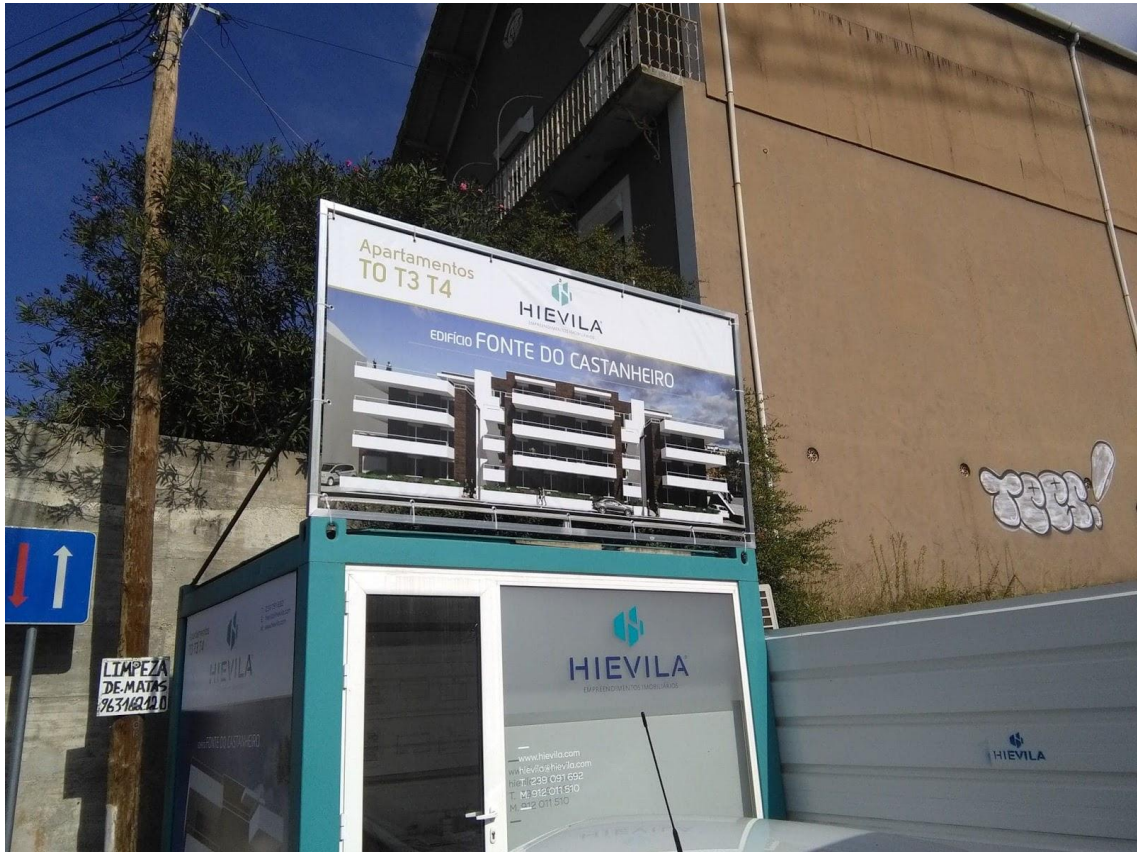
Anexo Nº3 - Edifício Fonte do Castanheiro (ainda em construção)
