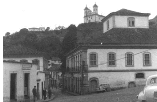
Figura 181 – Casa dos Contos – Ouro Preto/MG.
