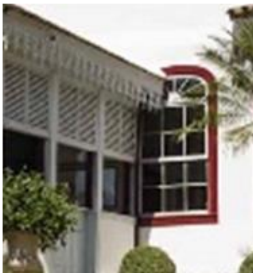
Figura 278 – Detalhe do beiral sobreposto à janela.
