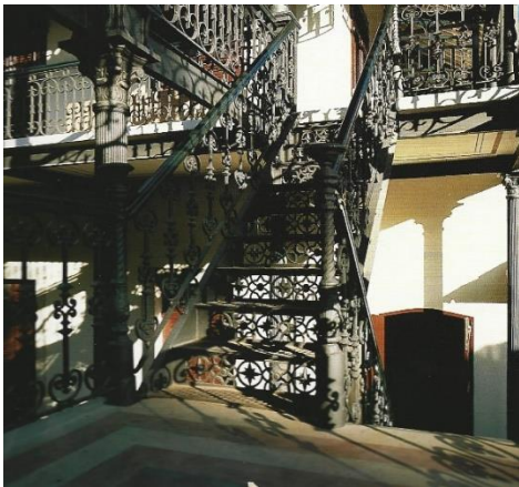
Figura 60 - Escadaria em ferro trabalhado
