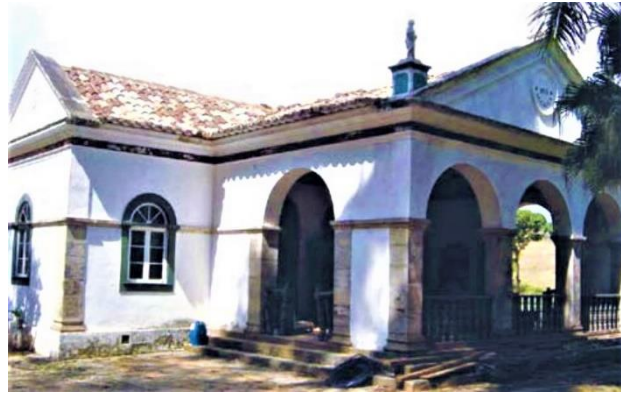
Figura 280 – Pórtico neoclássico da casa-grande
