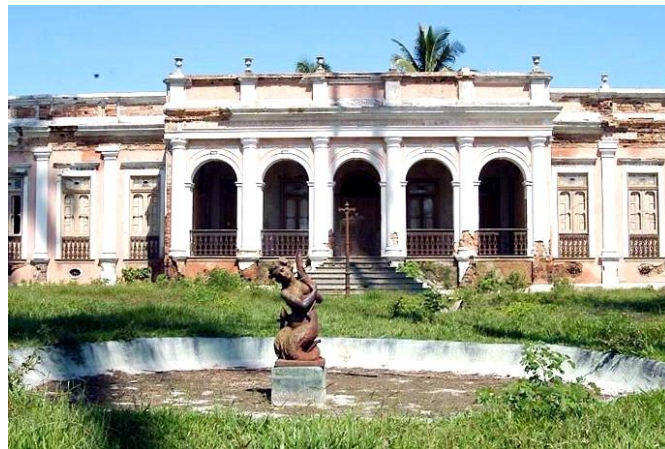
Figura 71 – Chafariz e espelho d'água em frente à casa do Engenho Mandiquera
