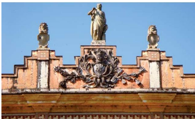
Figura 289 – Detalhe do vão central da platibanda.
