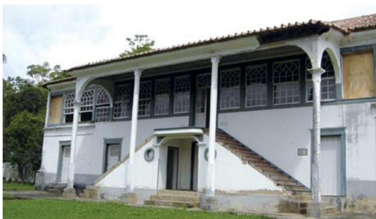
Figura 284 – Aspecto da cobertura da escadaria, adaptada à fachada.
