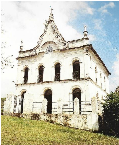
Figura 51 - Capela de São José. Construção anterior à casa-grande
