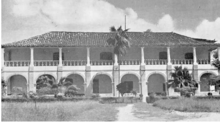
Figura 155 – Casa da Fazenda São Bento
