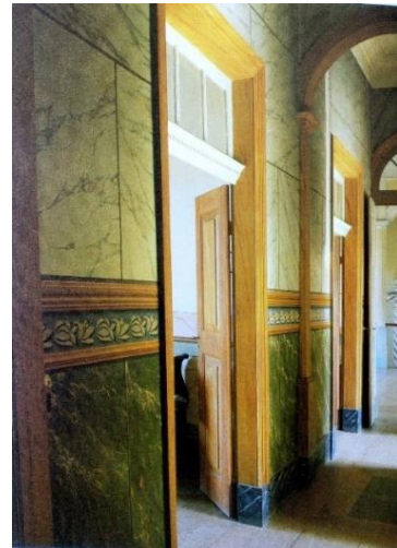
Figura 126 – Corredor com pintura Faux marbre.
