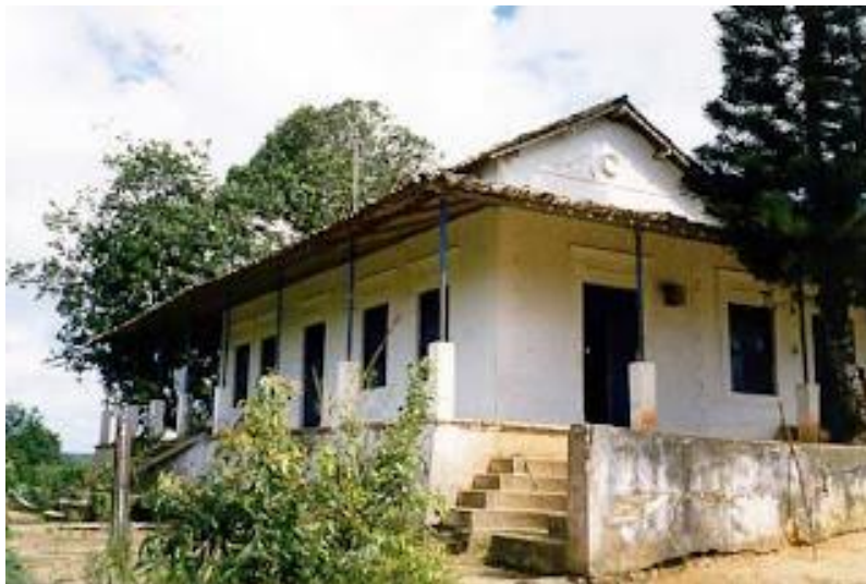
Figura 219 – Engenho Firmeza – a casa foi demolida, o que impede qualquer verificação de sua composição arquitetônica.
