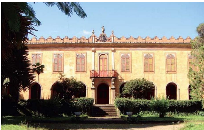
Figura 286 – Fachada da casa-grande da Fazenda Lordelo.
