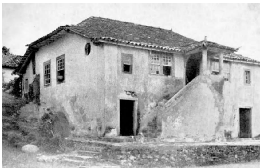
Figura 147 - Fazenda Ilha da Gipóia - RJ
