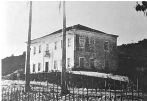
Figura 196 – Casa Grande do Engenho Riqueza (já destruído)
