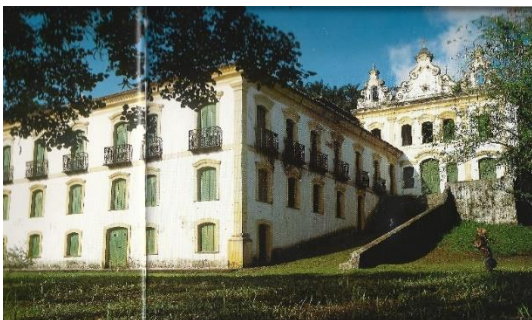
Figura 175 – Engenho Freguesia – PE
