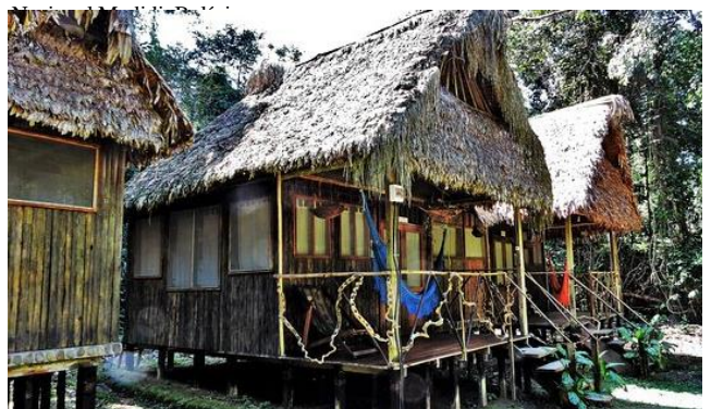
Alojamento construído com técnicas e materiais tradicionais no Parque
