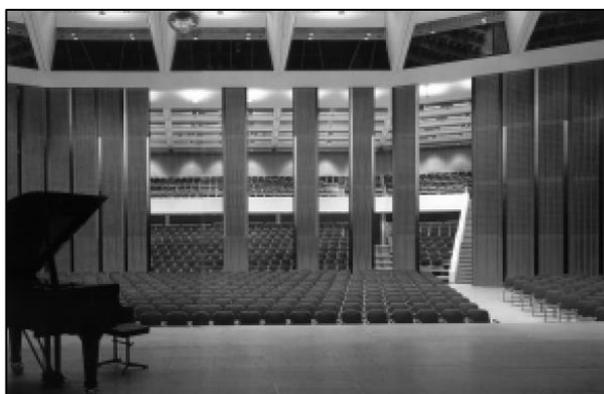
Figura 10: Divisórias móveis de alto isolamento acústico (Isbert, 1998).
