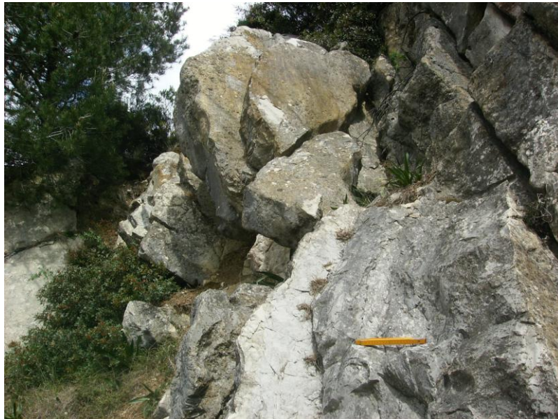
Figura 5.11 – Rutura planar no afloramento A10
